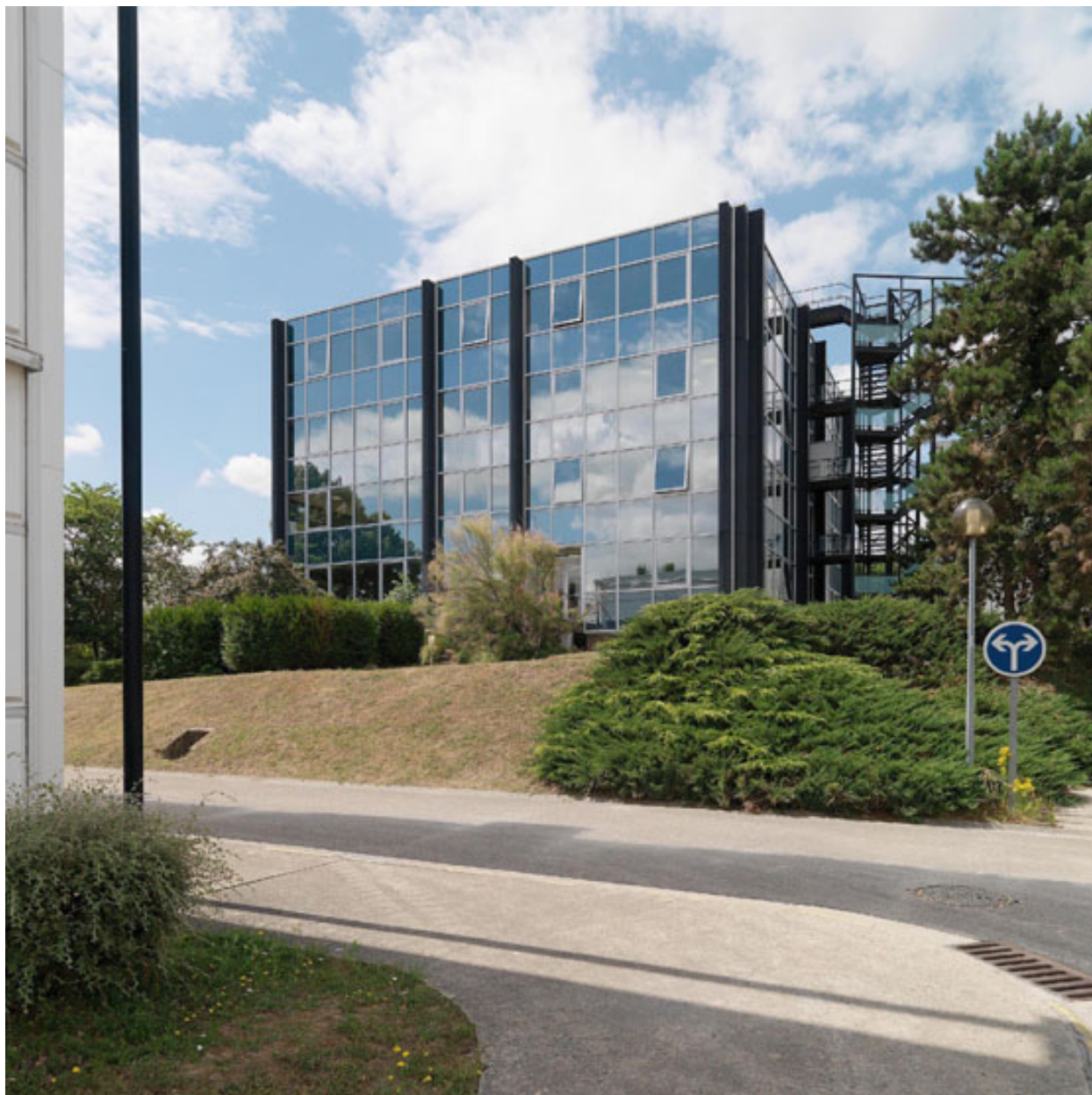
Bâtiment de bureaux bleu de 3 étages, rénové.
