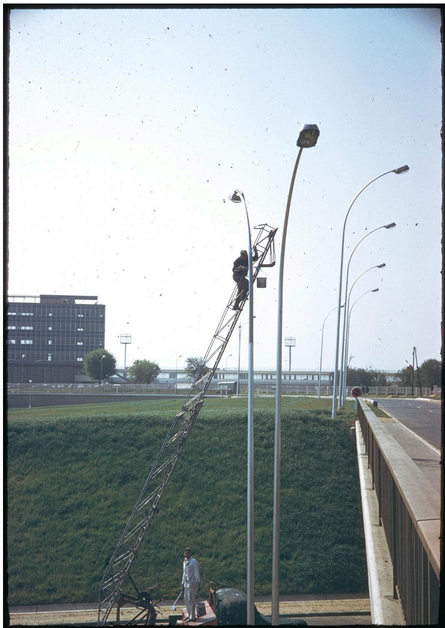
1956 1960 Construction du nouveau tracé de la Nationale 7, travaux de peinture sur les lampadaires.
