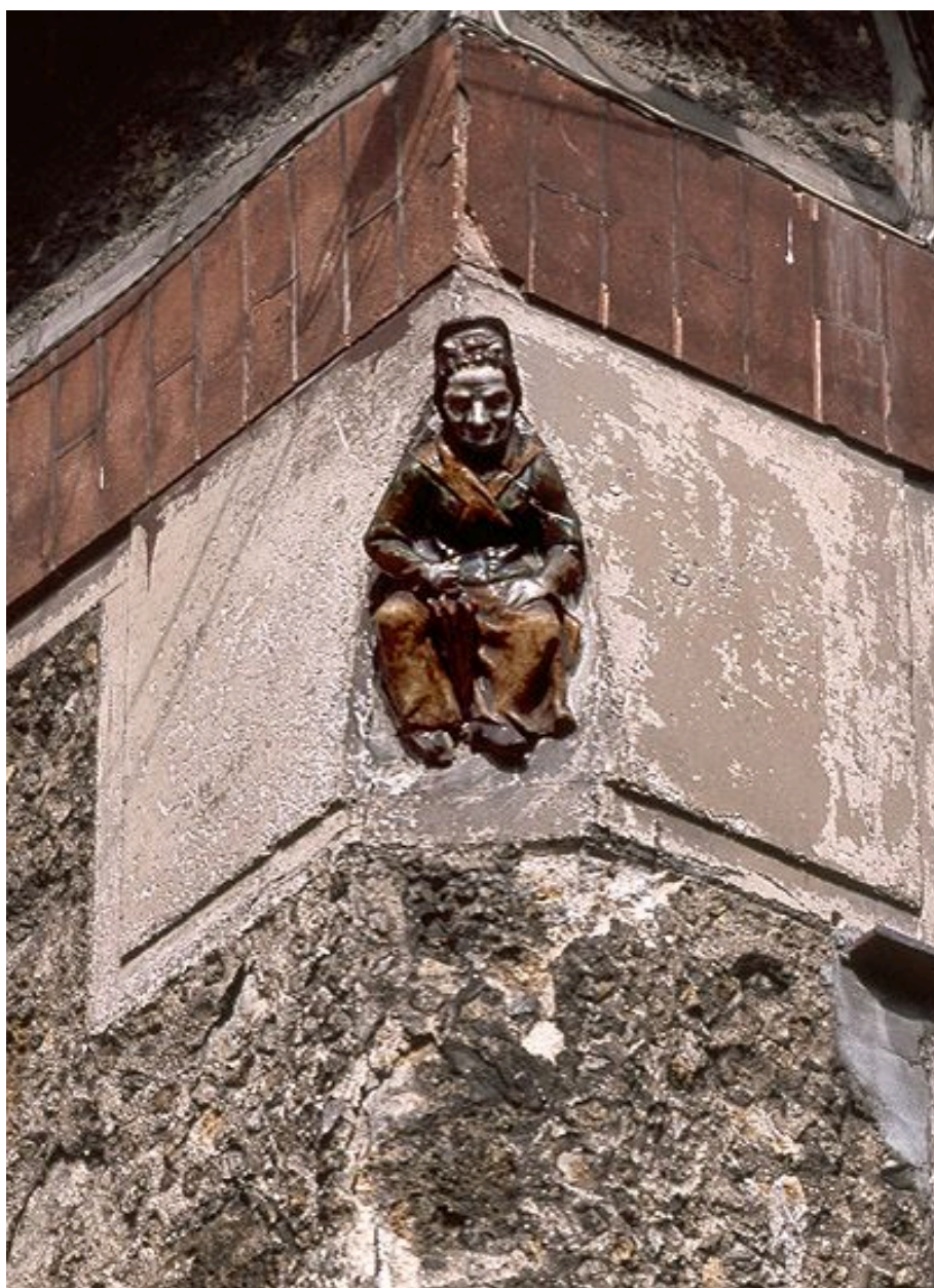
Détail d'un décor figuré en céramique vernissé placé dans un angle à la manière d'une console d'une maison, 19 rue Victor Basch.
