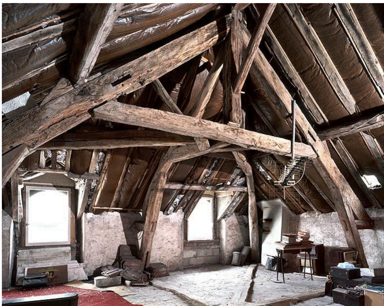
La charpente : vue d'ensemble.
