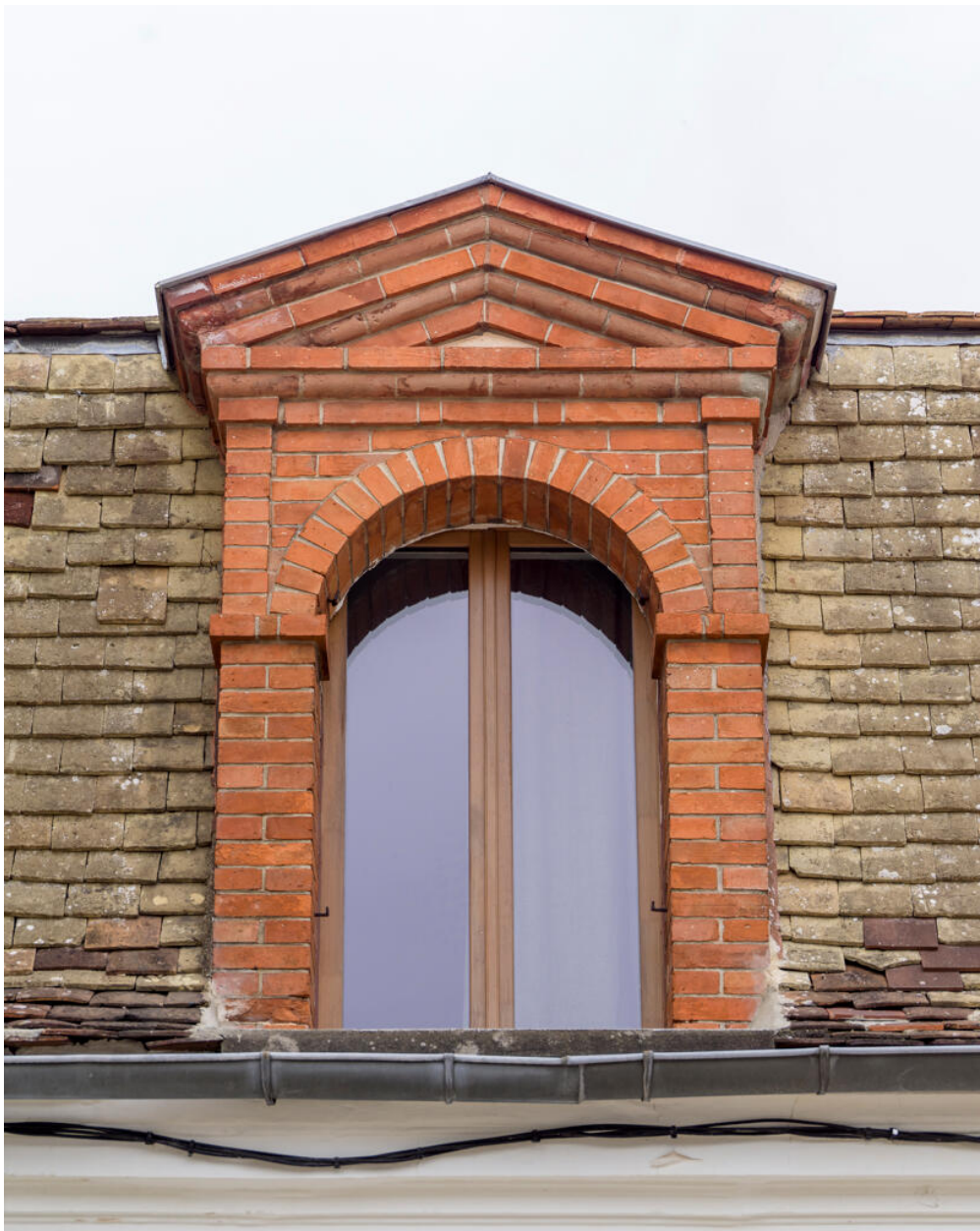
Vue de détail d'une des lucarnes.
