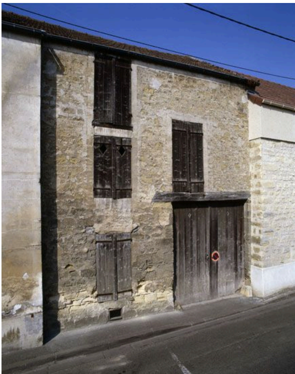
Une ancienne maison rurale à passage charretier rue de Pontoise.
