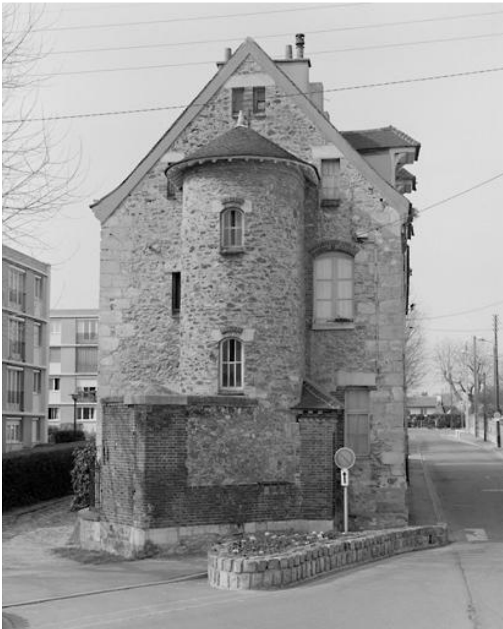
Vue du mur pignon et de la tourelle d'escalier sur la rue Robert-Schuman.
