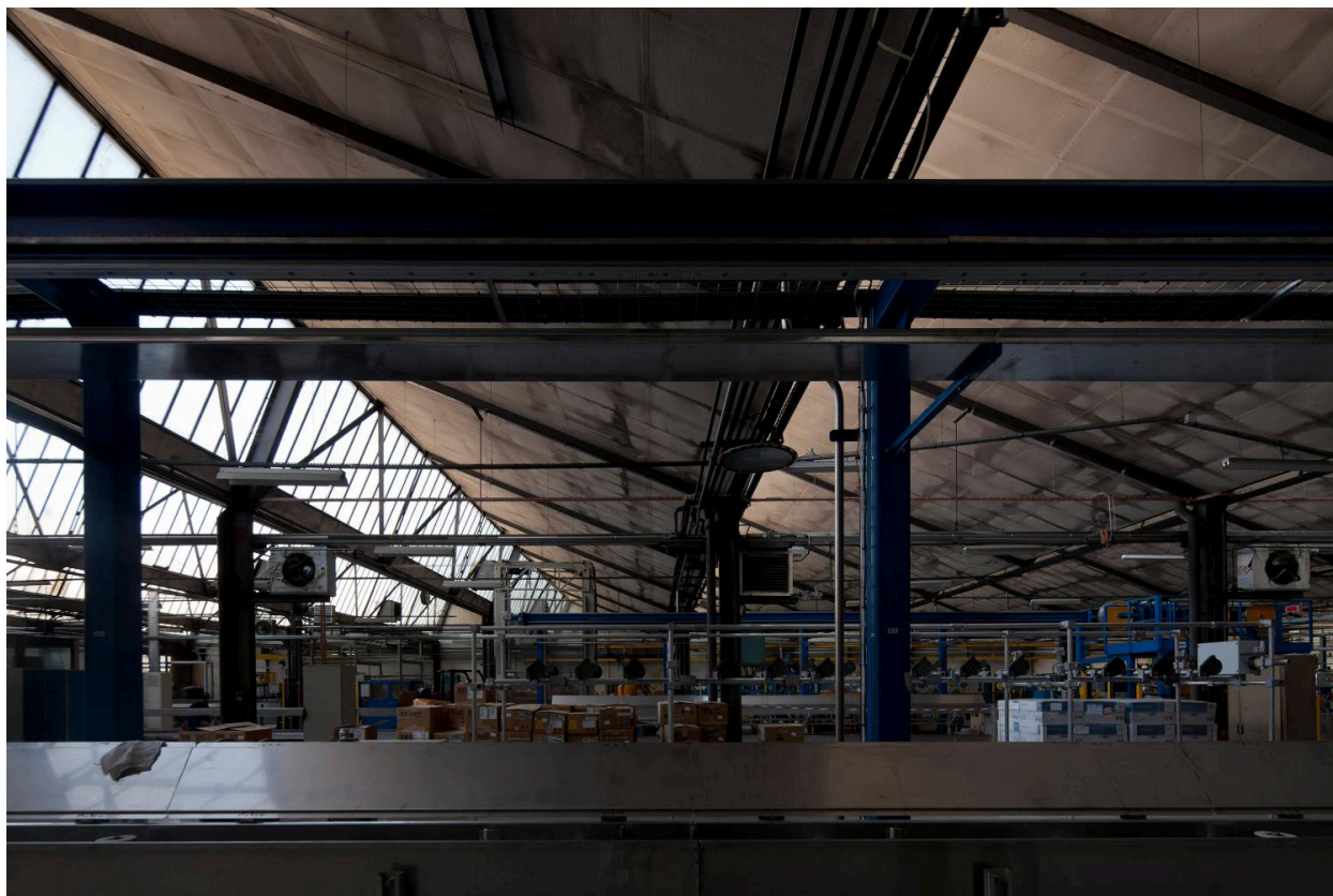
Atelier de fabrication CC1, vue des sheds depuis l'intérieur. (réf. Département de Seine-et-Marne : IVD77_2013_77_00324_NUCA)
