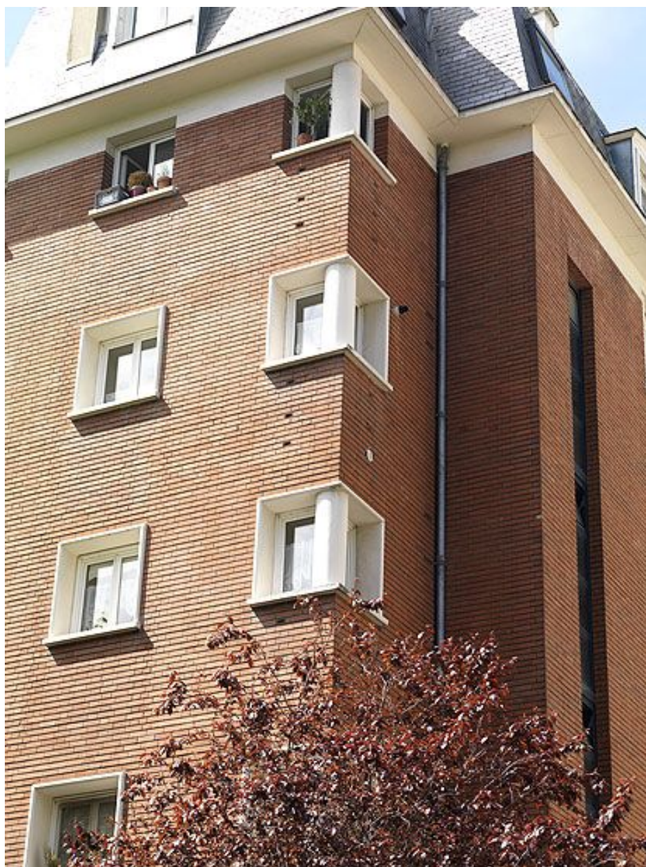
Vitry-sur-Seine, cité, rue Ambroise-Croizat. Détail de fenêtres
