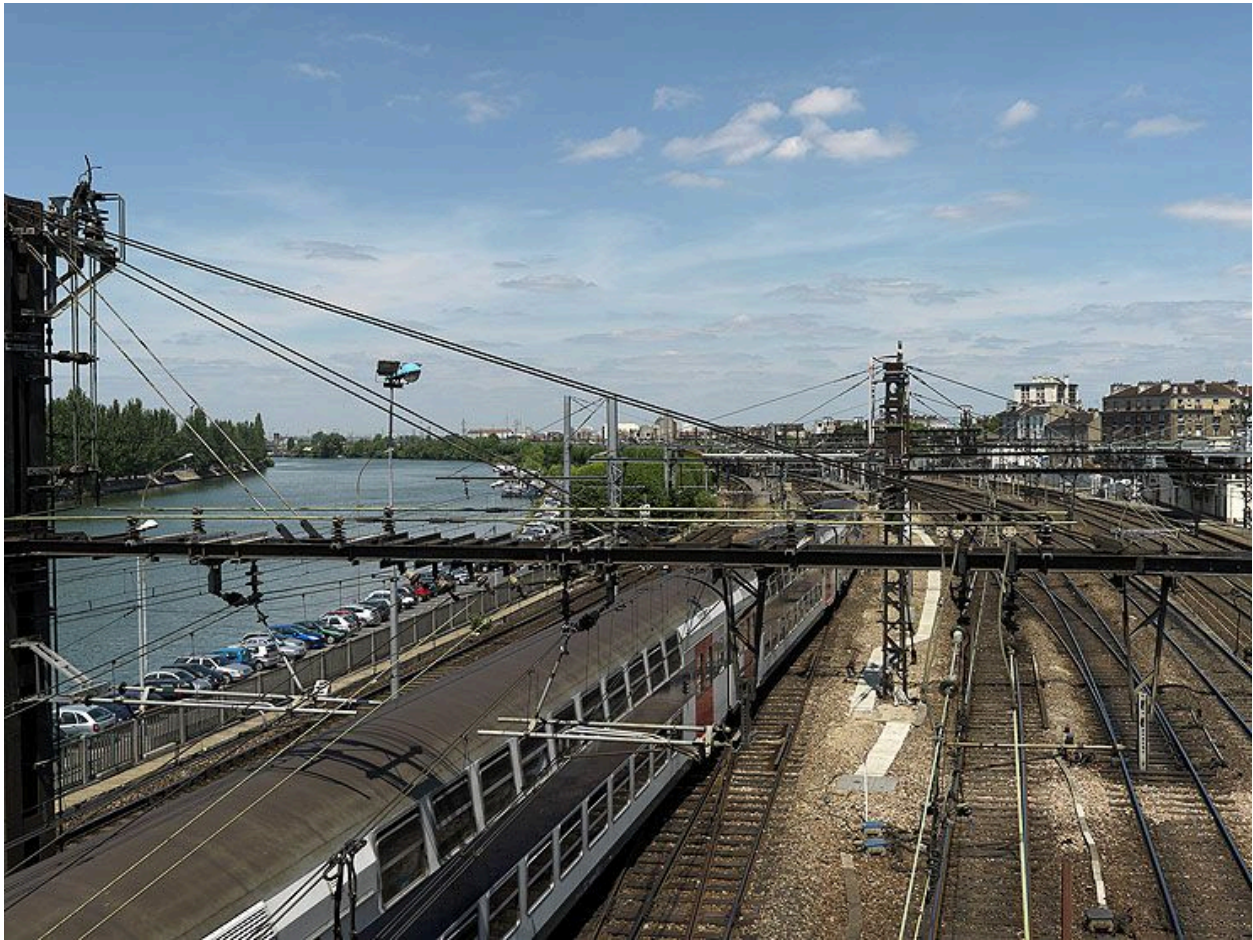
Villeneuve-Saint-Georges. Les voies de chemin de fer, depuis le pont de Villeneuve, vers le nord.
