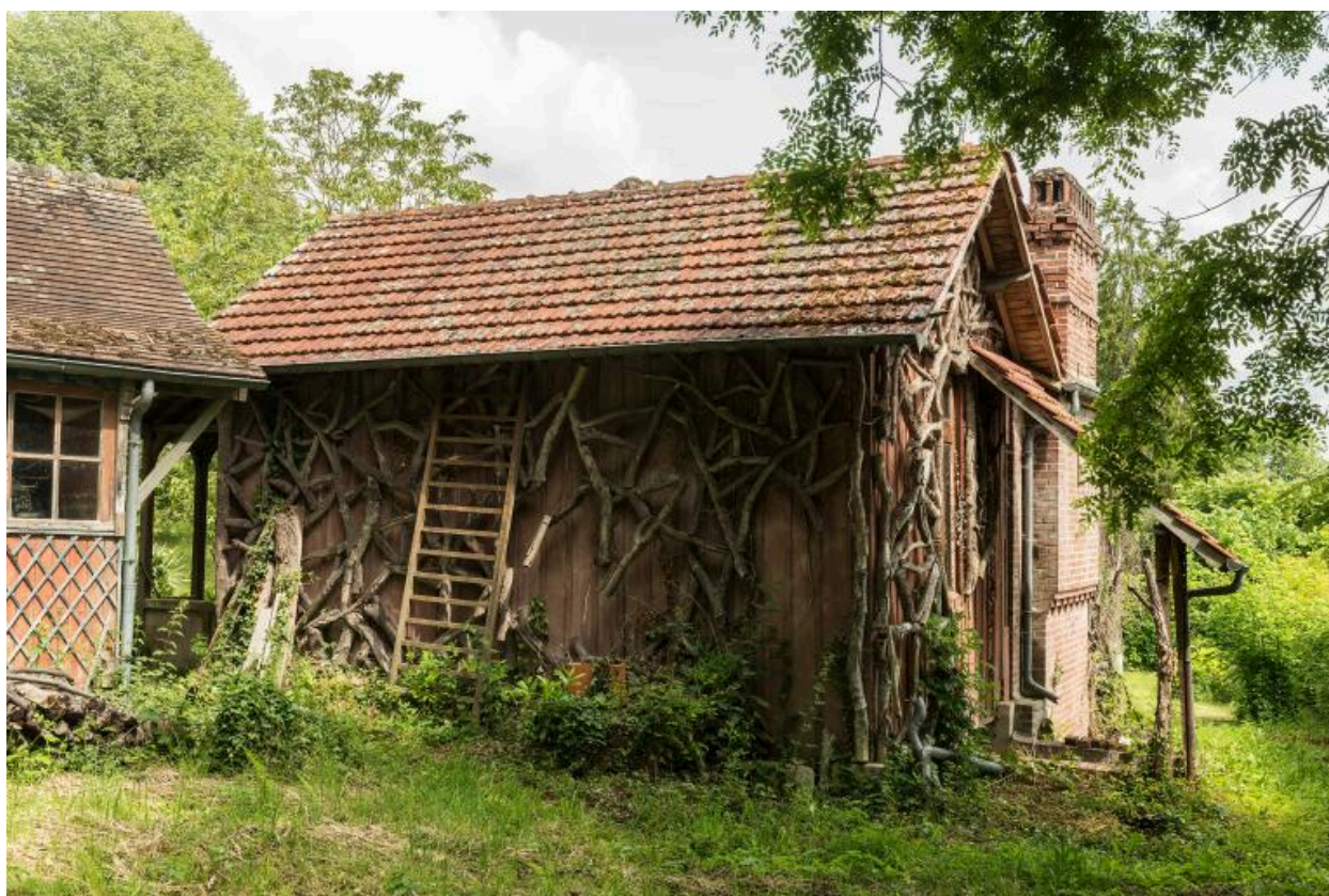
Vue des façades arrières des ateliers (1)
