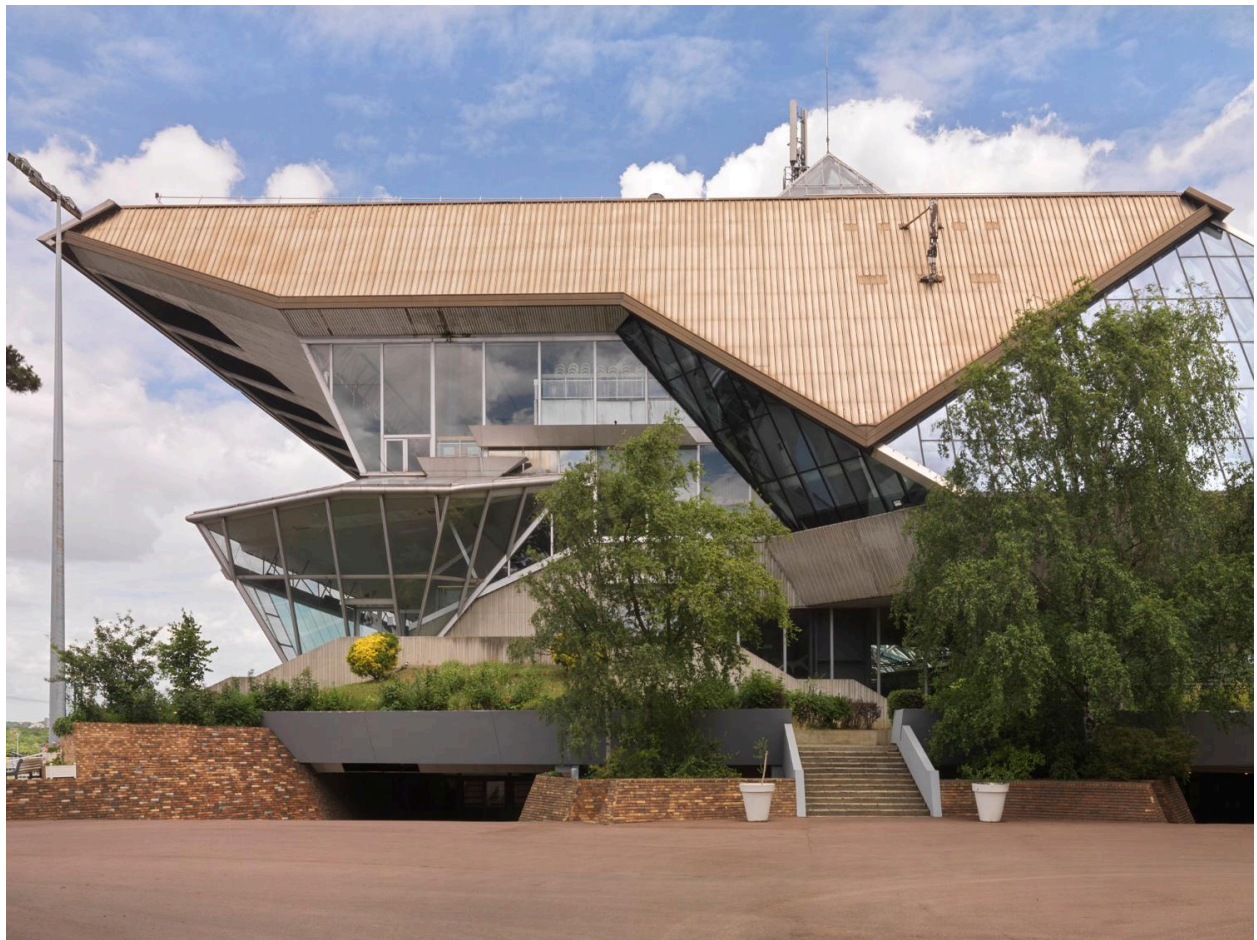
Vue générale de la tribune et de son porte-à-faux.
