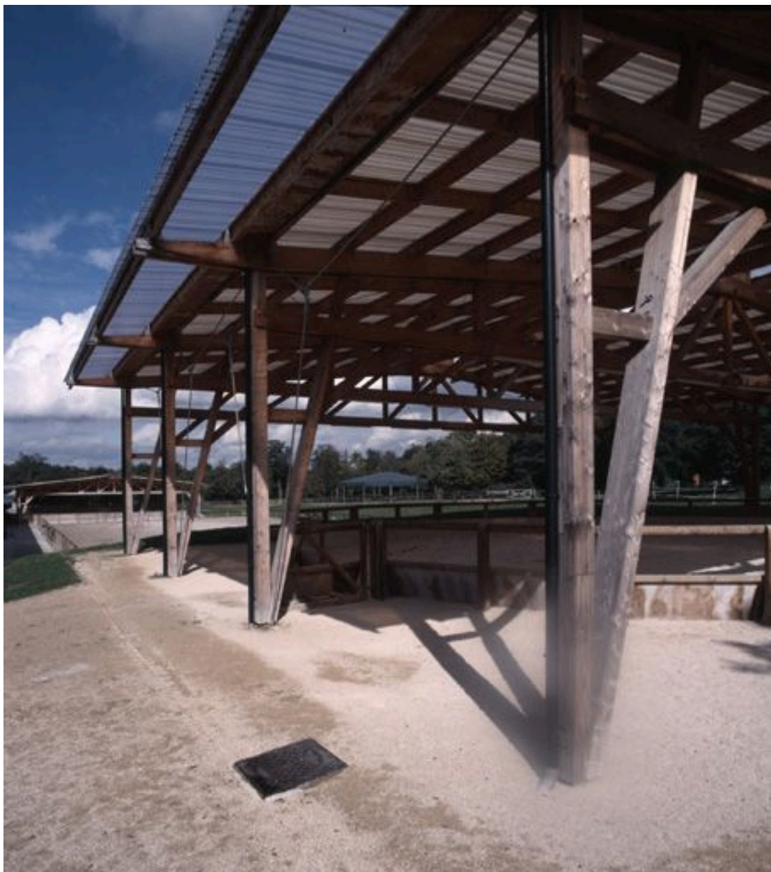
Détail de la couverture du manège.
