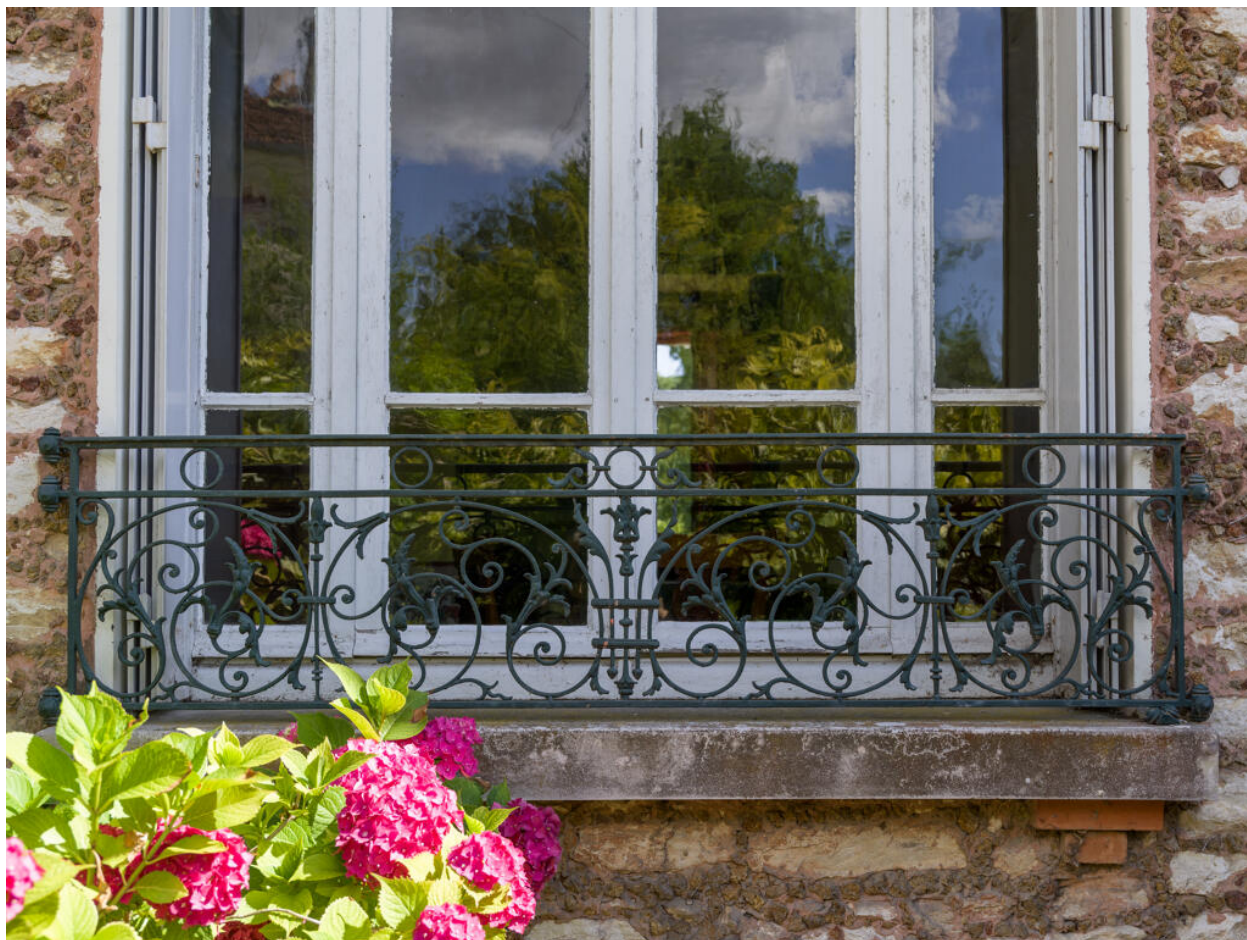
Détail de la baie du rez-de-chaussée du 25 rue Saint-Pierre.
