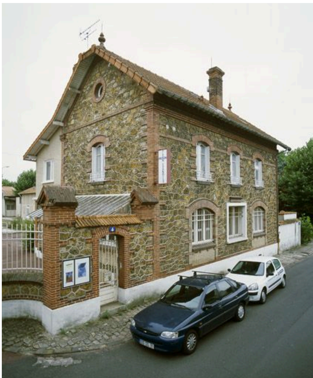
Bâtiment de bureaux situé à droite de l'entrée le long de la rue de Châtillon.
