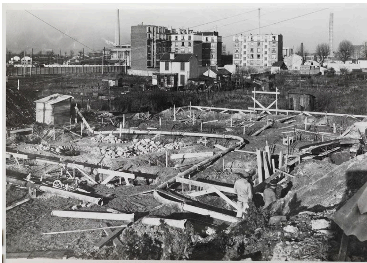
Chantier de construction du groupe scolaire Paul Langevin. Photographie, 1950. (AM Romainville)
