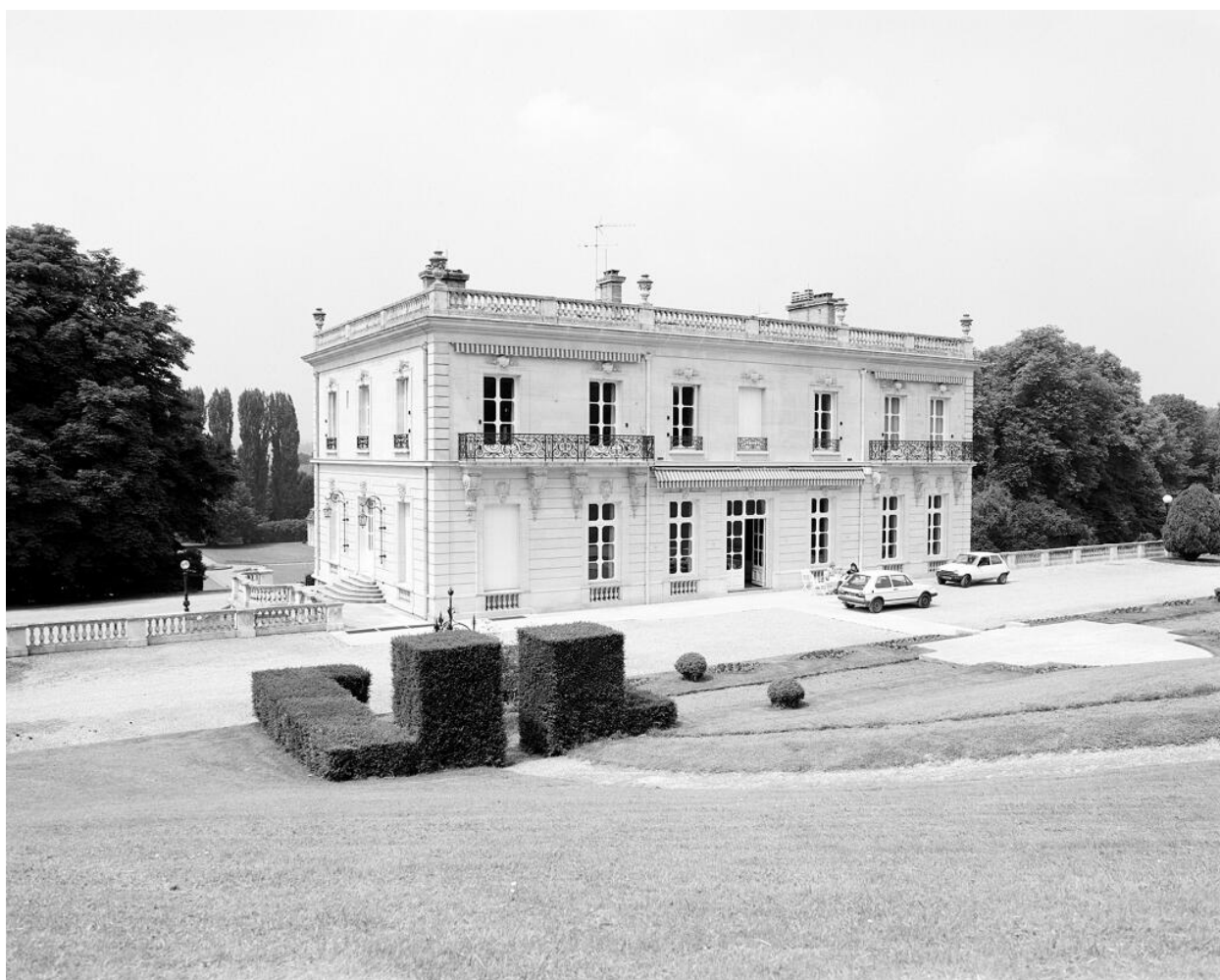
La façade antérieure, vue de trois-quarts.
