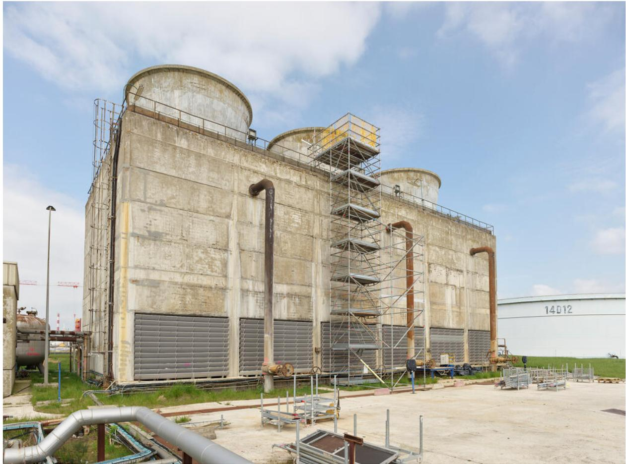
Zone du traitement des eaux (Unité 420). Tour aéroréfrigérante "SCAM", utilisée pour refroidir les eaux procédé pour le fonctionnement des Unités Ouest. Au fond à droite, bac de réserve d'eau incendie (20 000 m<sup>3</sup>).
