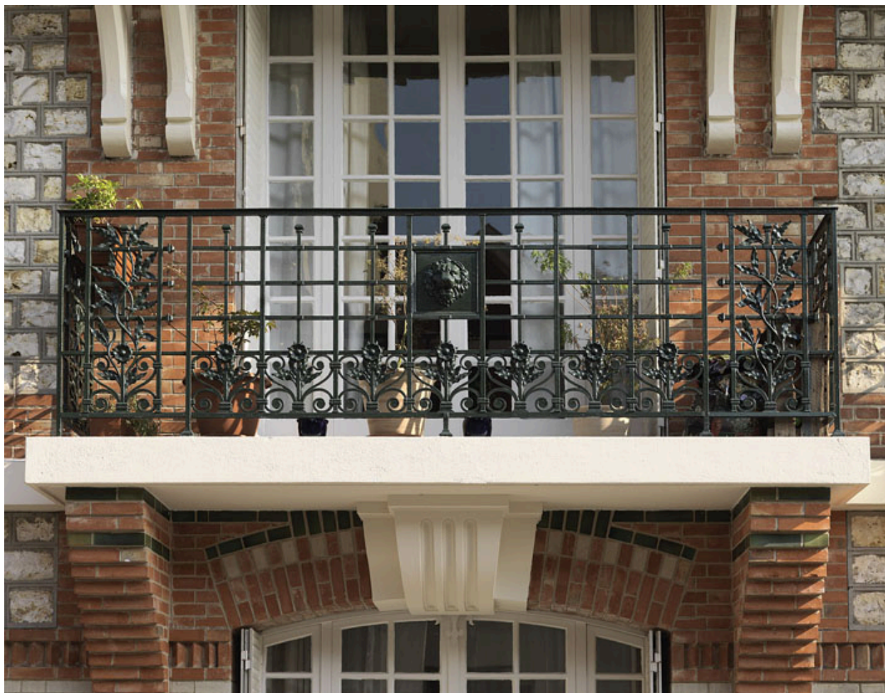
Détail de l'un des balcons de l'immeuble au n° 8 de la rue Pélégot
