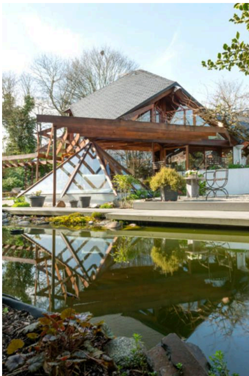
Vue de la façade principale : détail de l'avant-corps Ouest avec pergola et véranda pyramidale.
