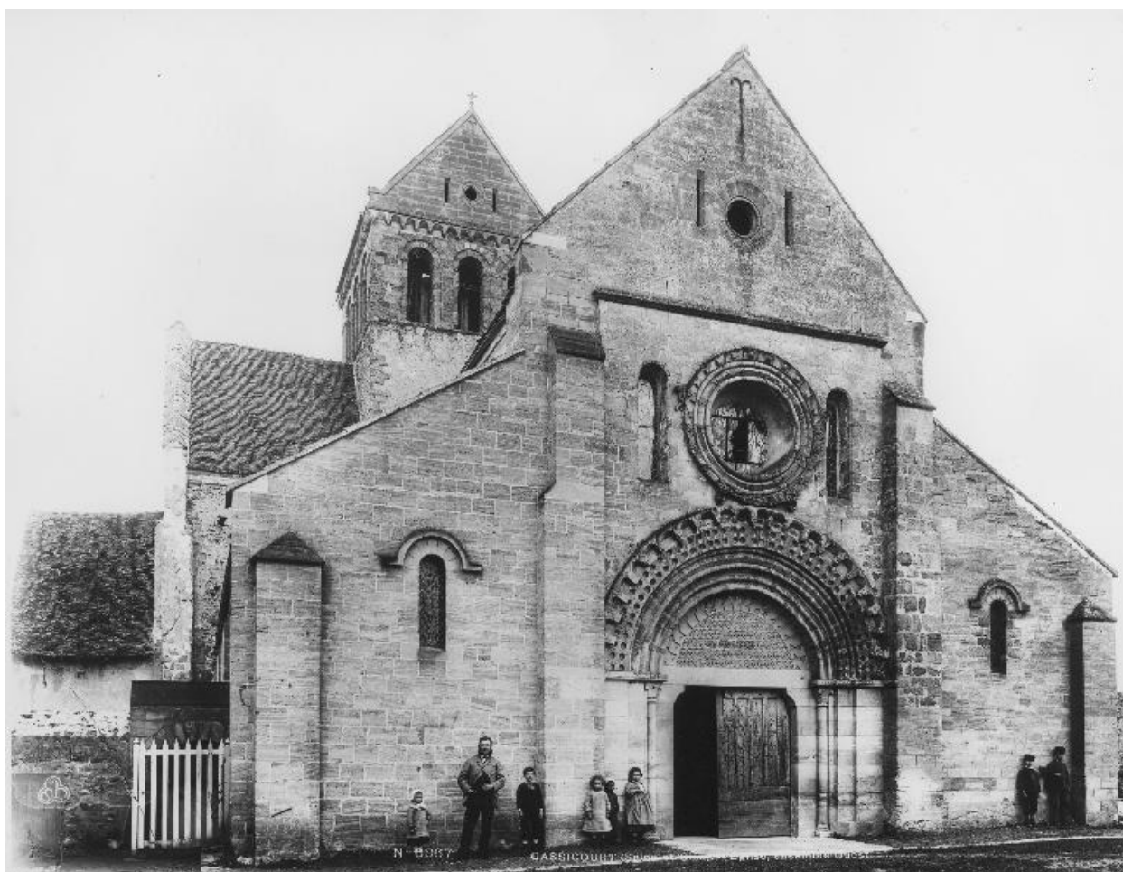
Vue de l'église après dégagement des bâtiments qui la jouxtaient. (Fonds CREDOP)
