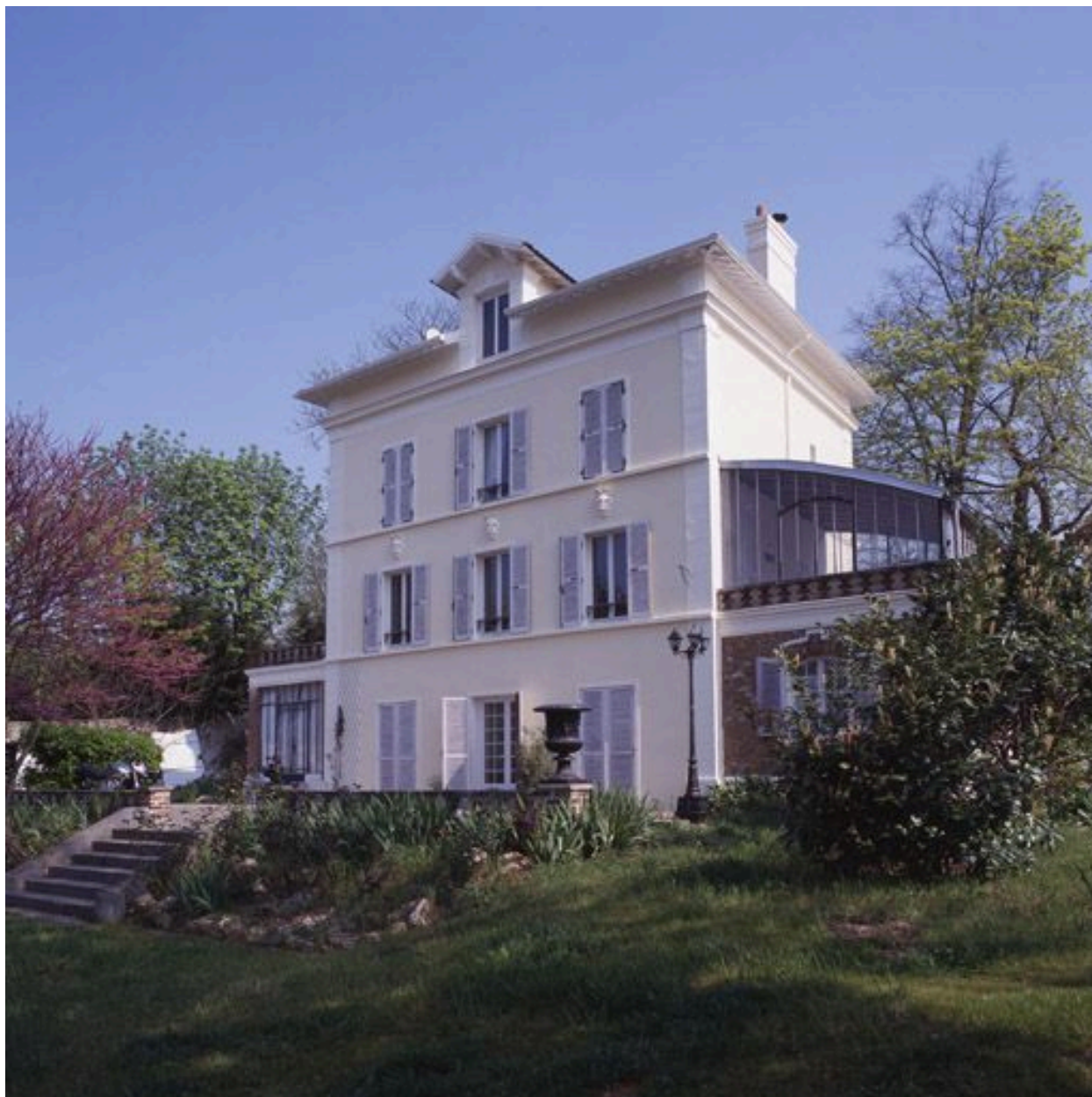
Vue de la façade arrière.
