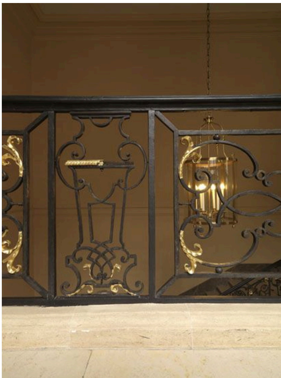
Panneau droit, détail et pilastre.
