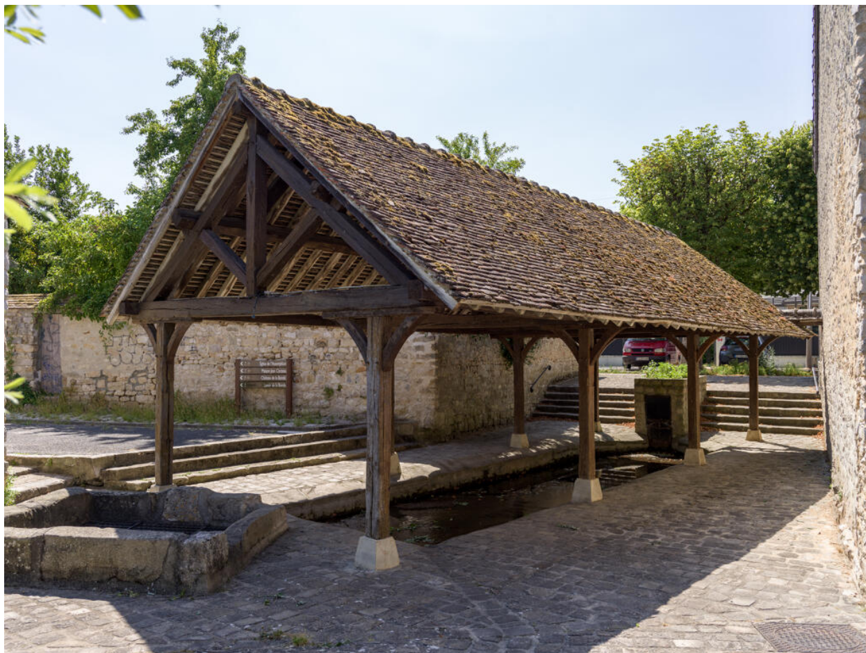
Vue générale depuis l'angle nord-est.
