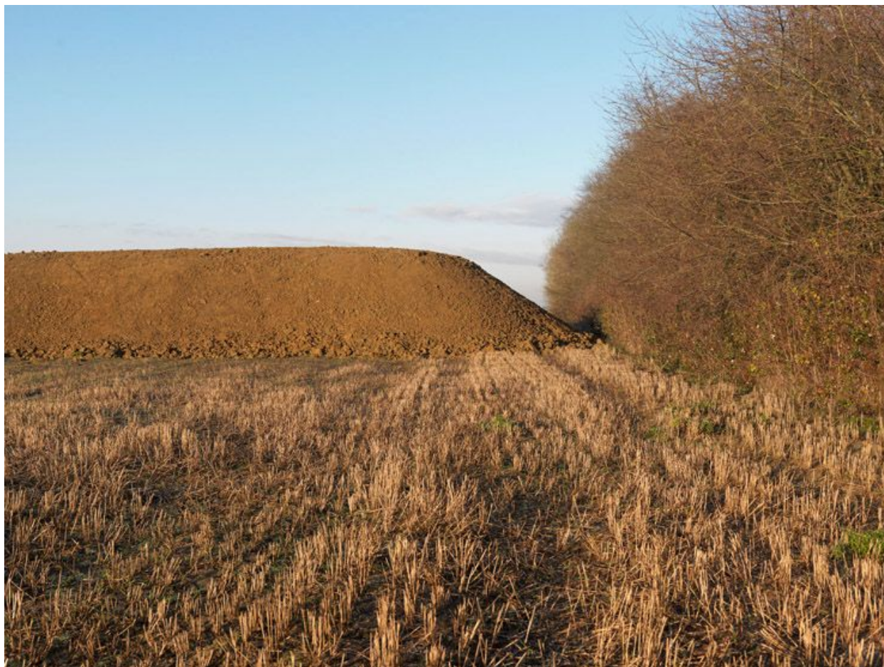
Palaiseau, avenue de la Vauve. Vue des champs lors des premiers terrassement du chantier du campus EDF.
