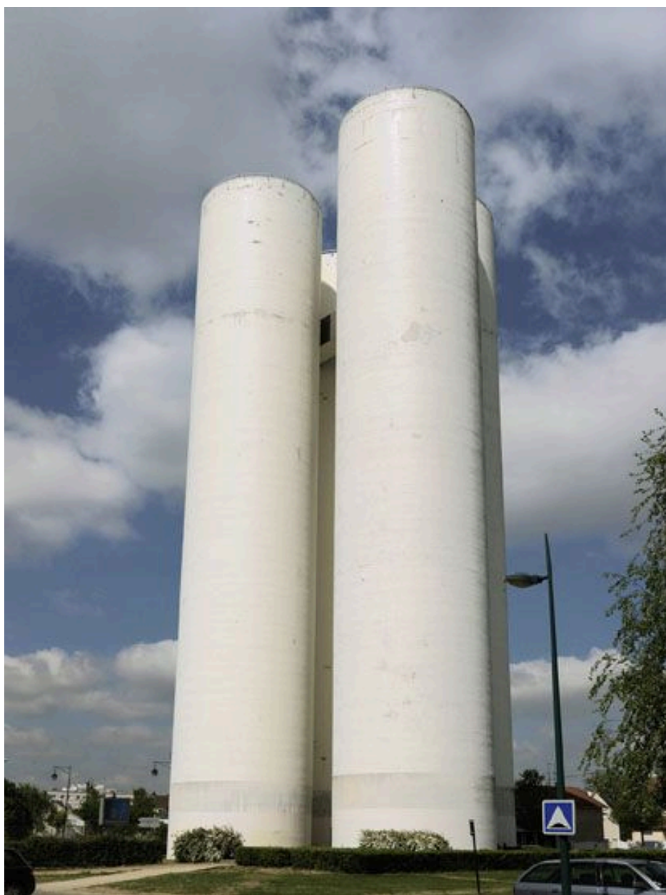
Vue générale du château d'eau.
