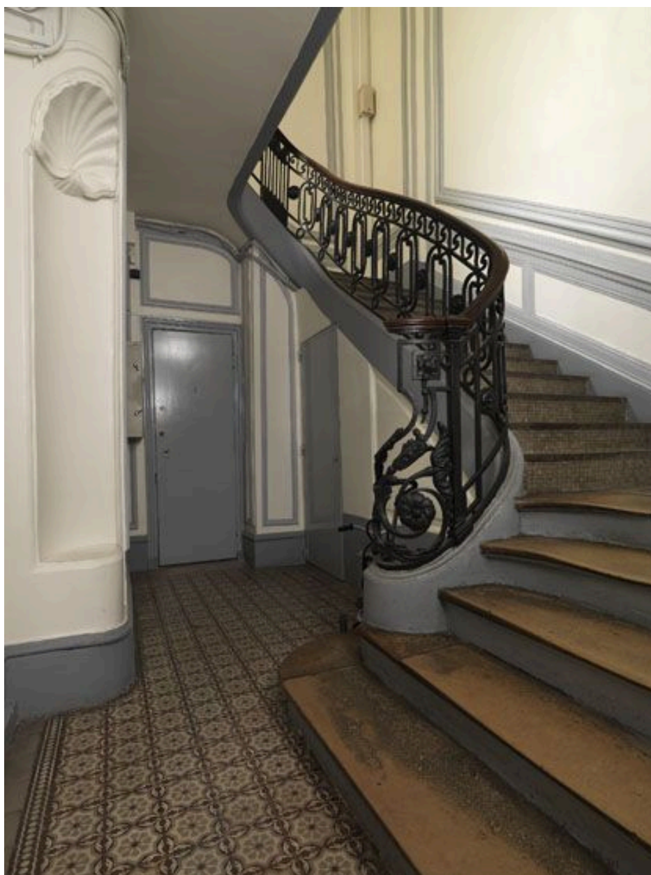
Vue d'ensemble de la première volée.
