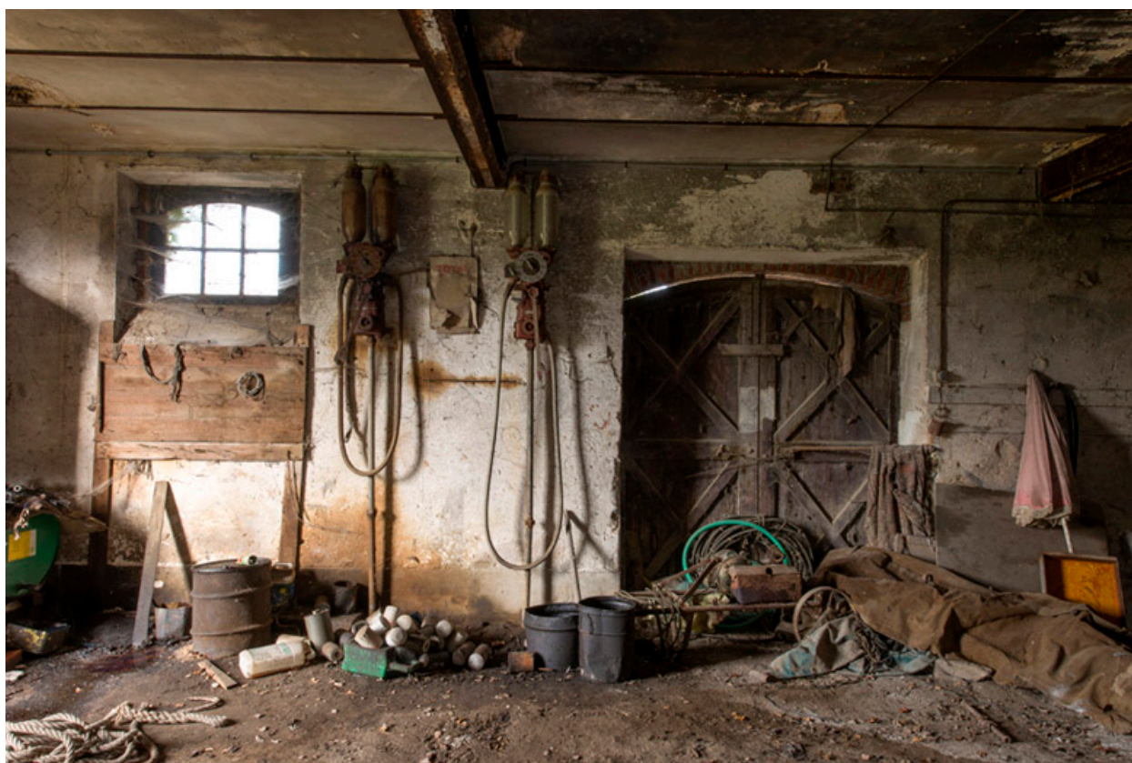
Intérieur de l'annexe de l'angle nord est.
