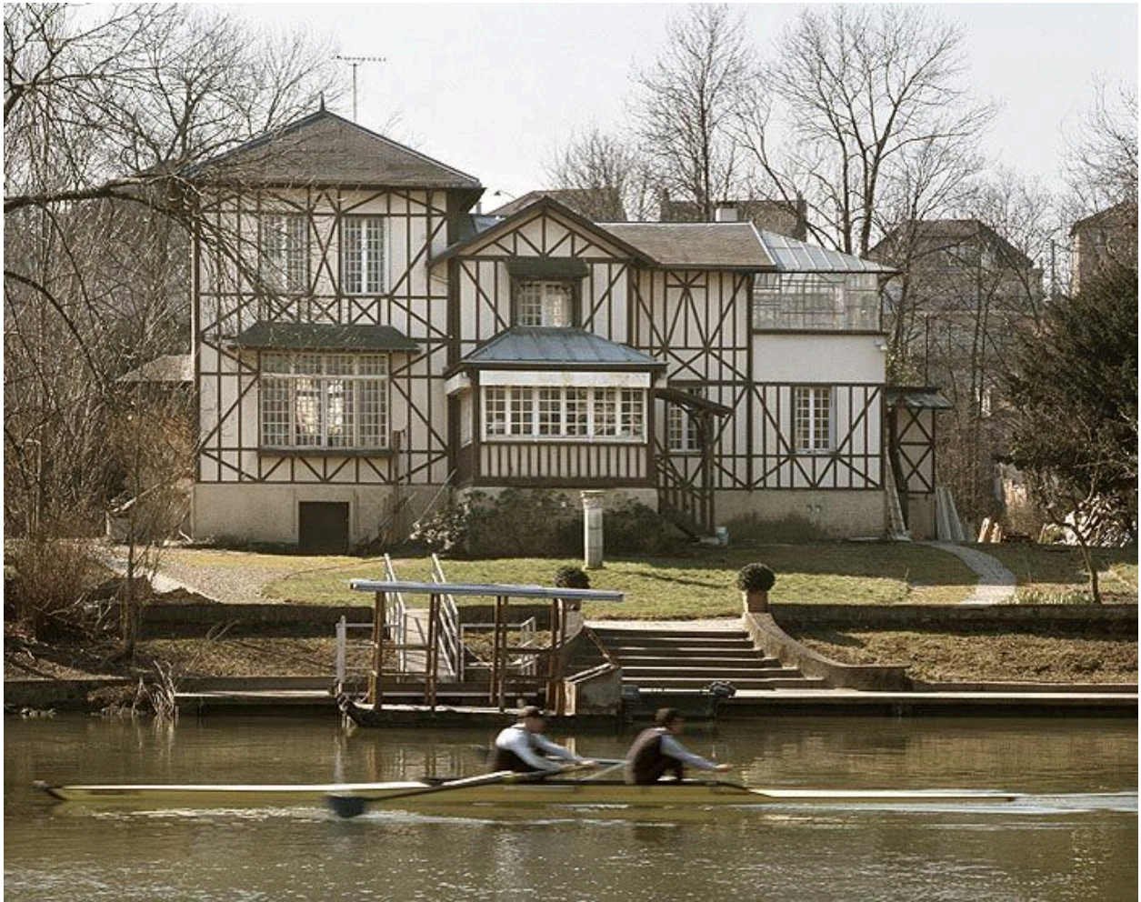
Vue d'ensemble depuis le quai du Perreux de l'île des Loups.
