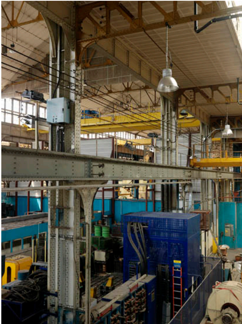
Vue intérieure. Plateforme d'essais. Entreprise Jeumont-Electric. Poteaux et structure métallique.
