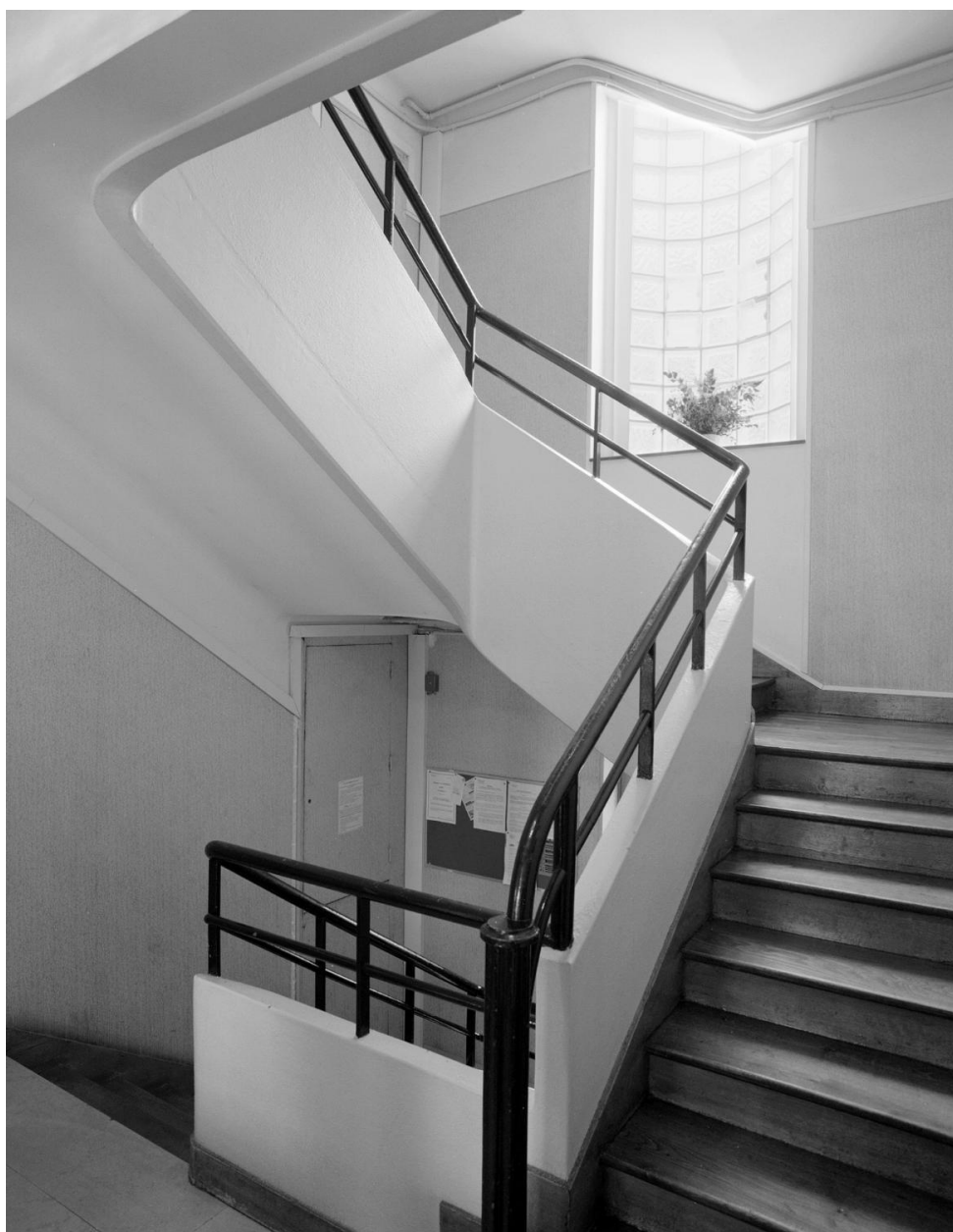
Une des cages d'escalier (n° 1).
