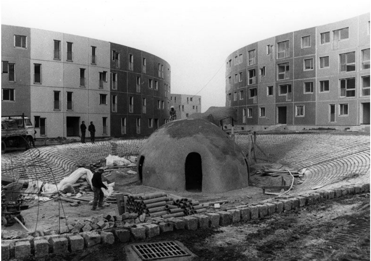
La Noé. Photographie du chantier prise le 17 avril 1973, de la seconde enceinte de la place du Bestiaire. Au premier plan, l'hippopotame vu de dos et son enclos en cours de construction. (Mairie de Chanteloup-les-Vignes).
