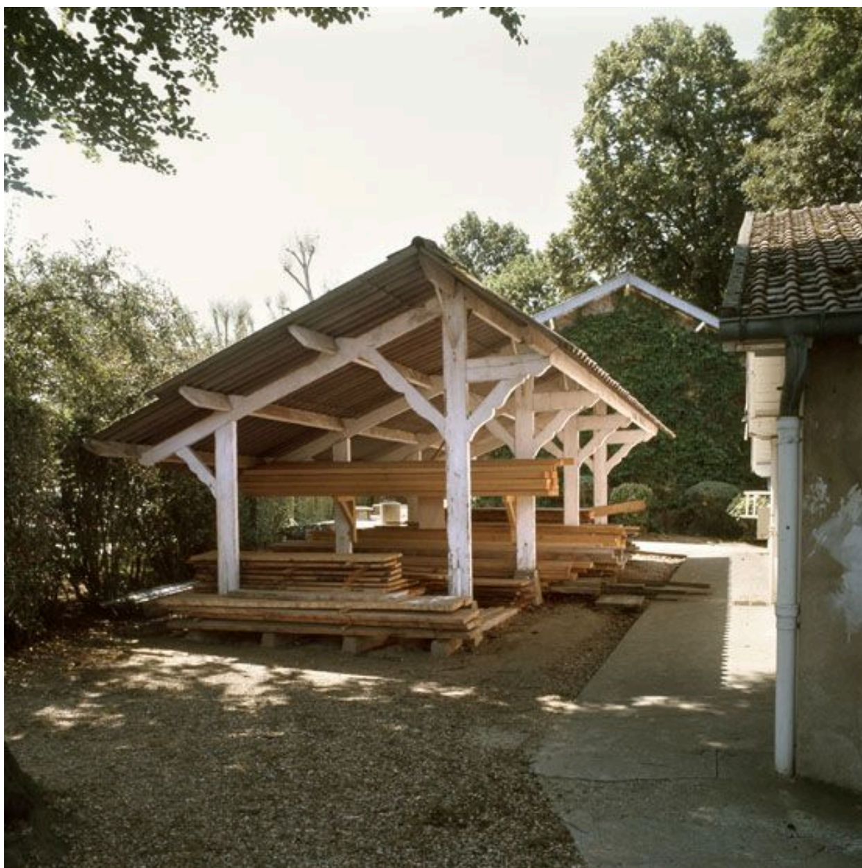
Abri à bois à côté des ateliers.
