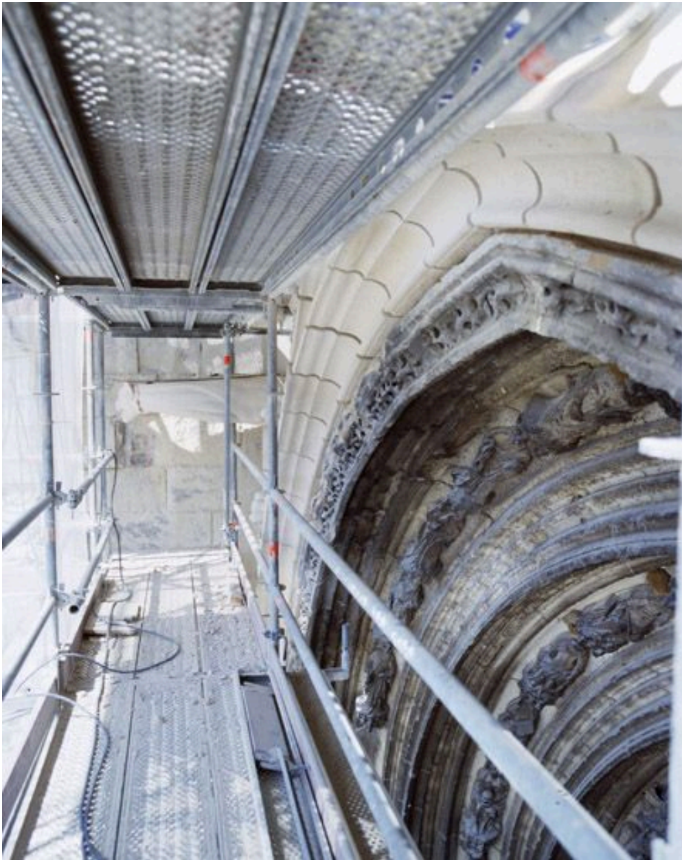
La façade occidentale : vue du chantier de restauration de la base de la tour nord (2008). L'échafaudage au sommet du portail Saint-Jean-Baptiste, vu depuis le sud.
