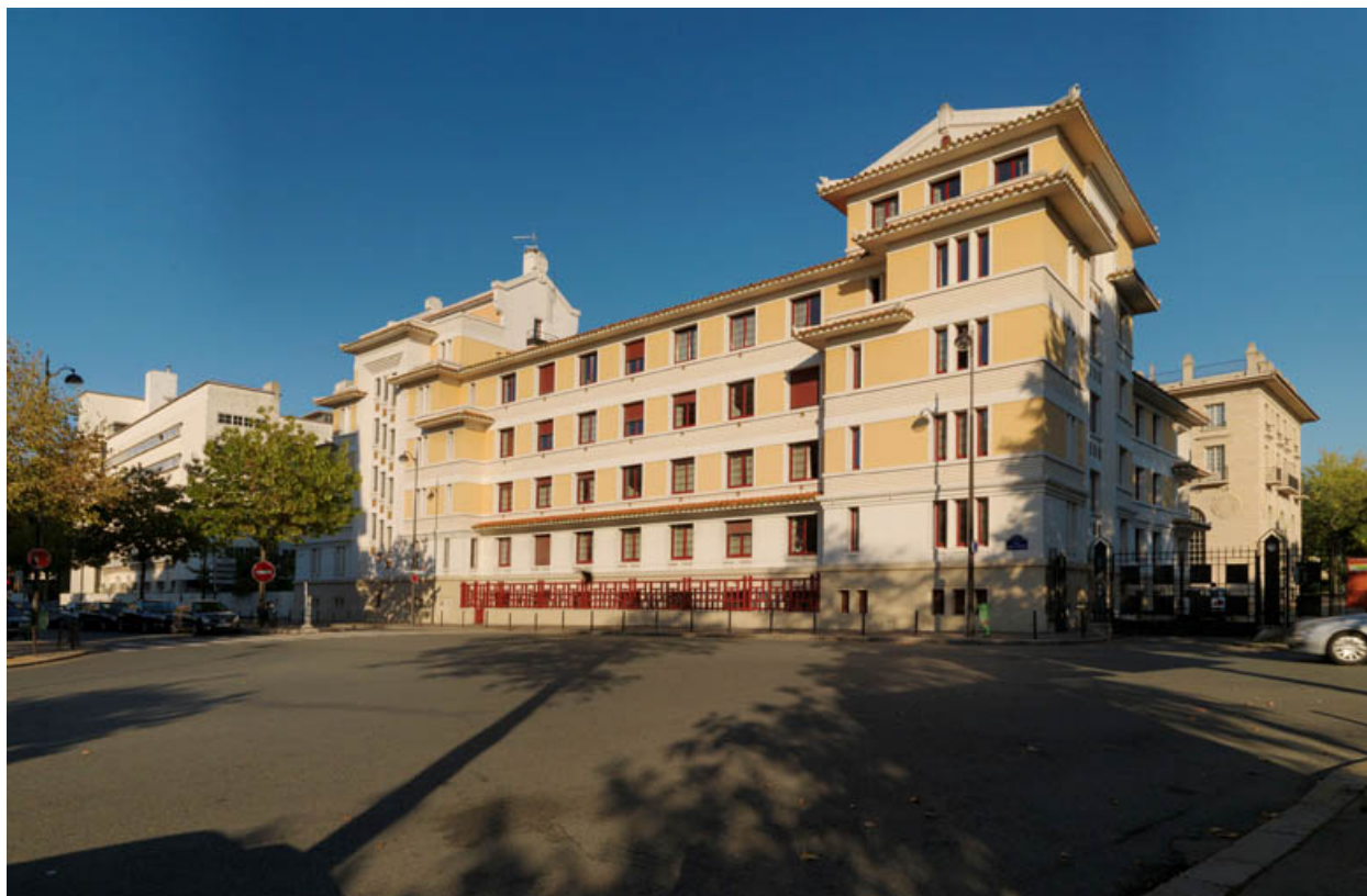
Vue de la façade ouest, en bordure de la rue Emile-Faguet.
