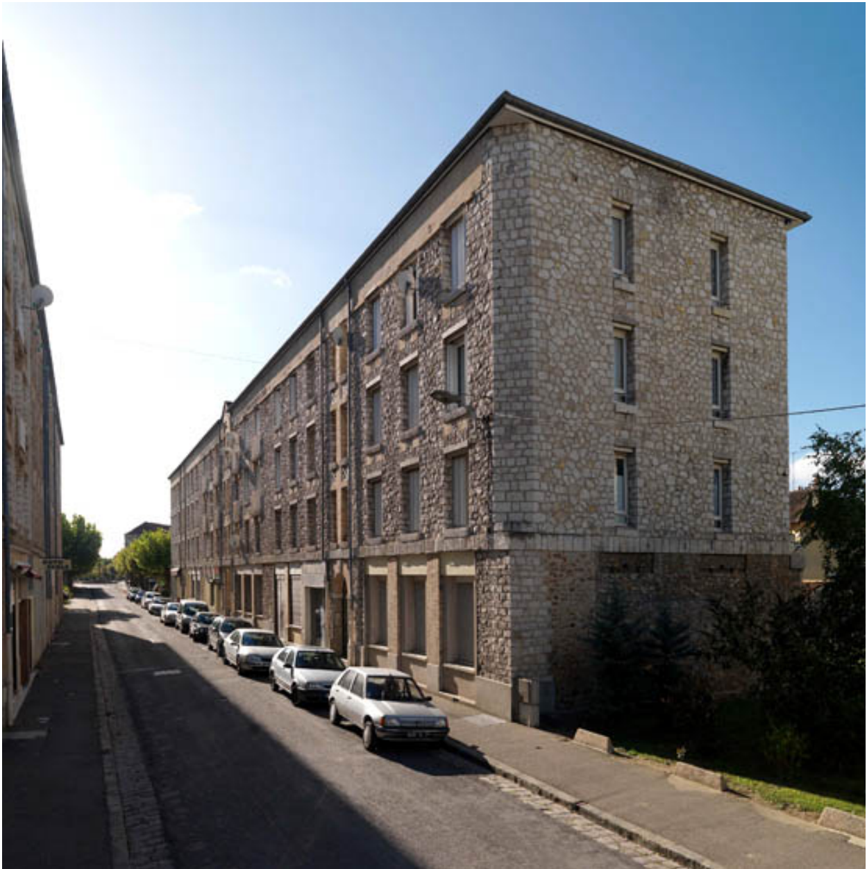
4/14 rue Georges Clemenceau. Immeuble en meulière blanche (1902-1903).
