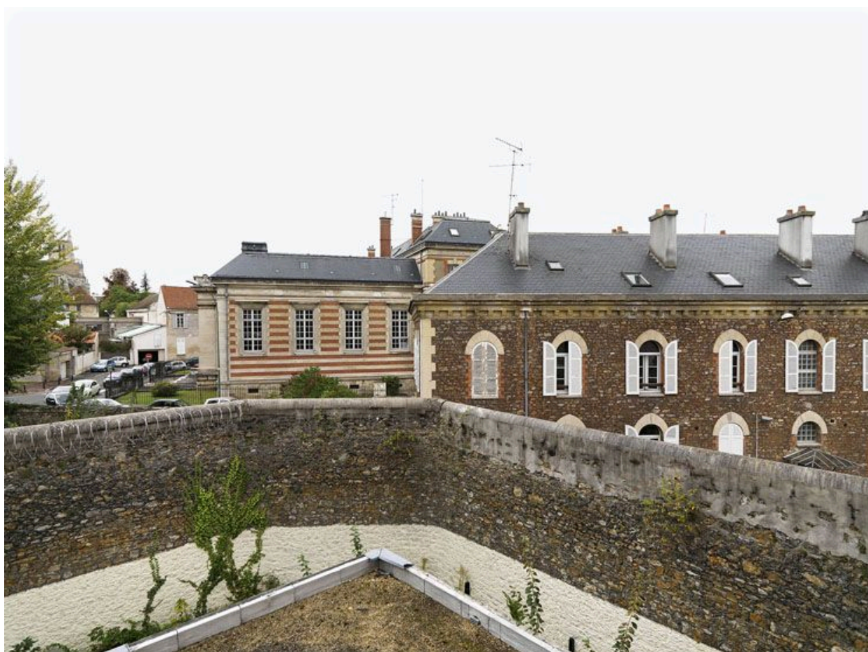
Le mur d'enceinte de la maison d'arrêt, la gendarmerie et le palais de justice.
