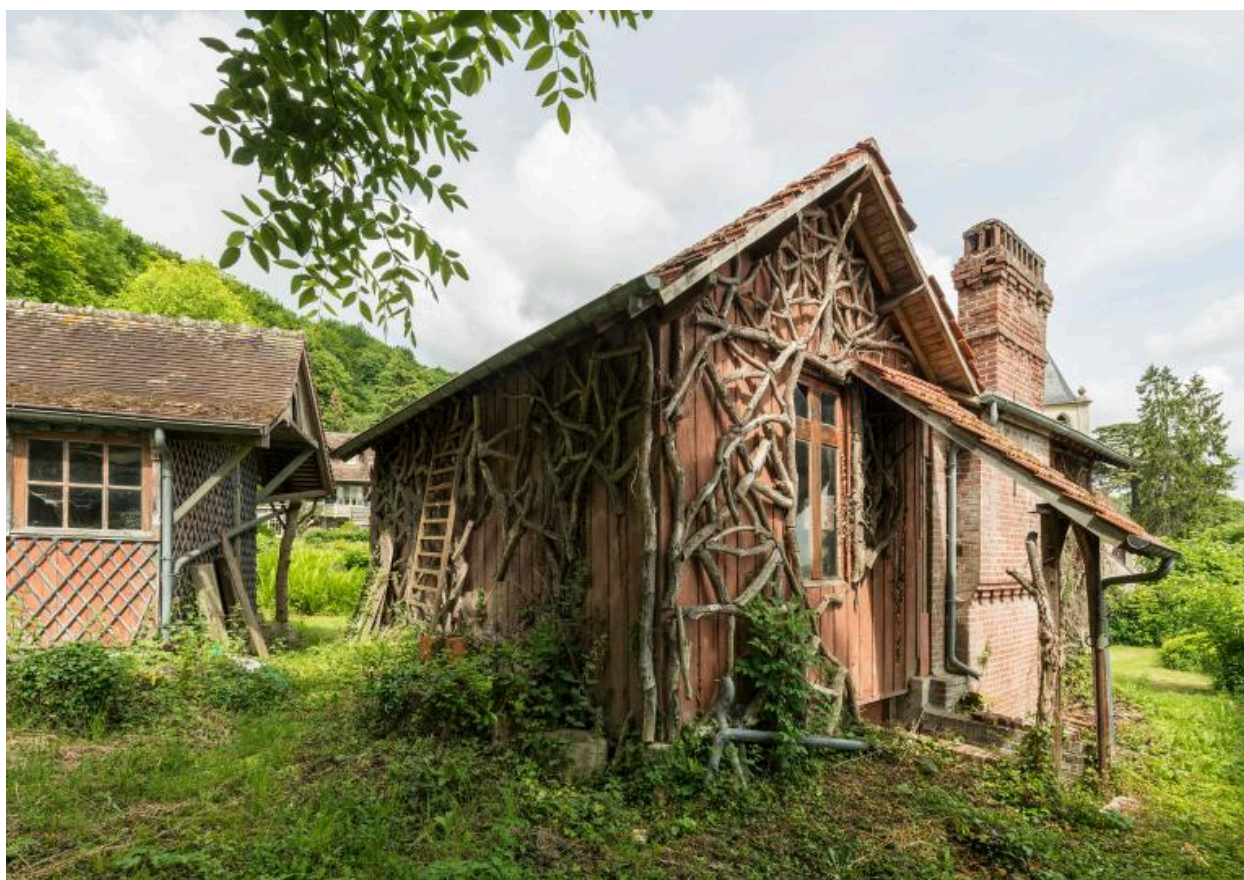
Vue des façades arrières des ateliers (4)
