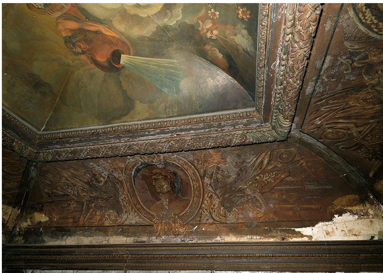
Le plafond peint : détail de la partie est.
