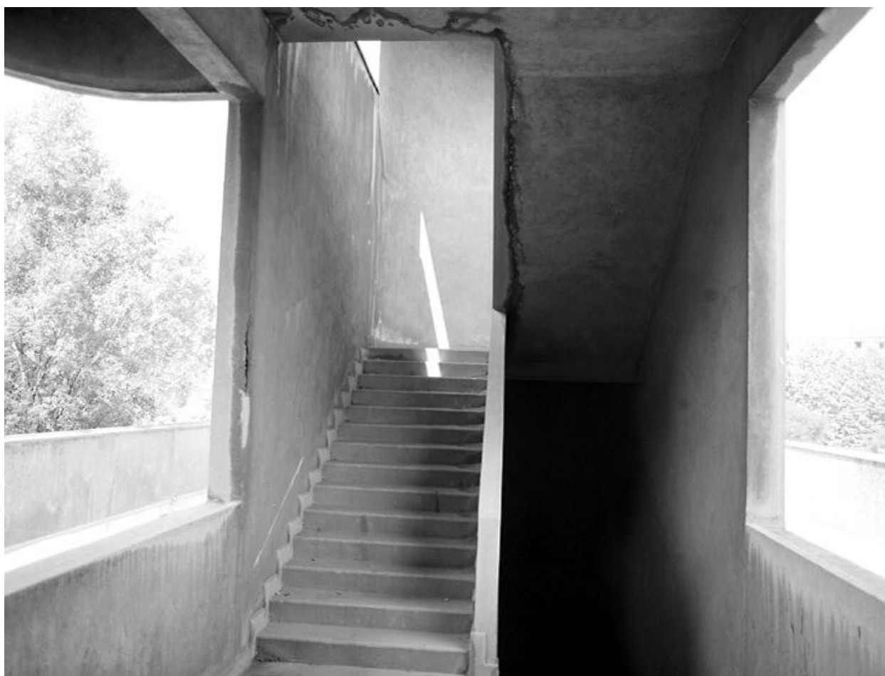
L'escalier d'accès à la tribune, vue prise vers l'extrémité de la façade. Groupe scolaire dit groupe scolaire Karl-Marx
