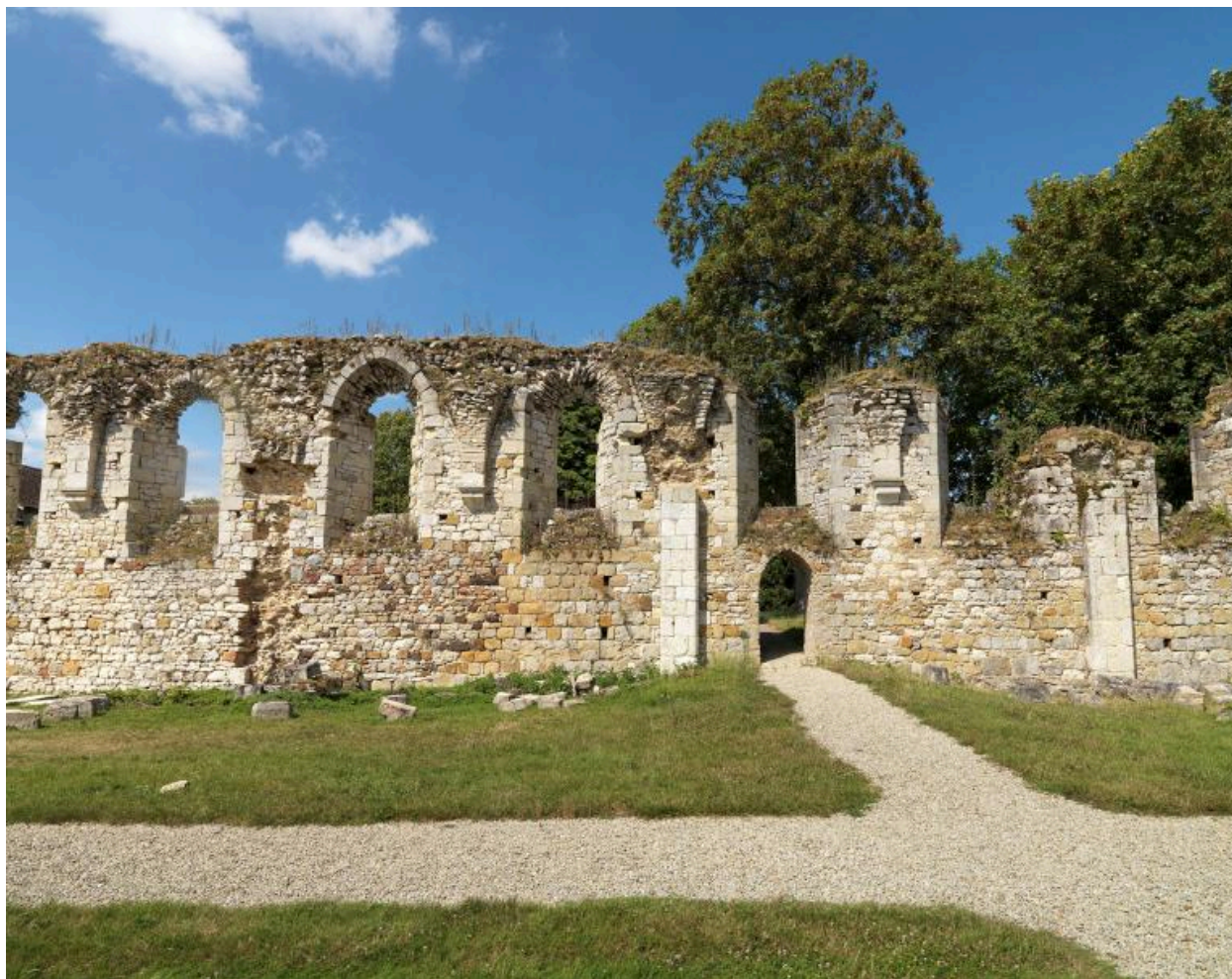
Mur gouttereau nord de la nef.
