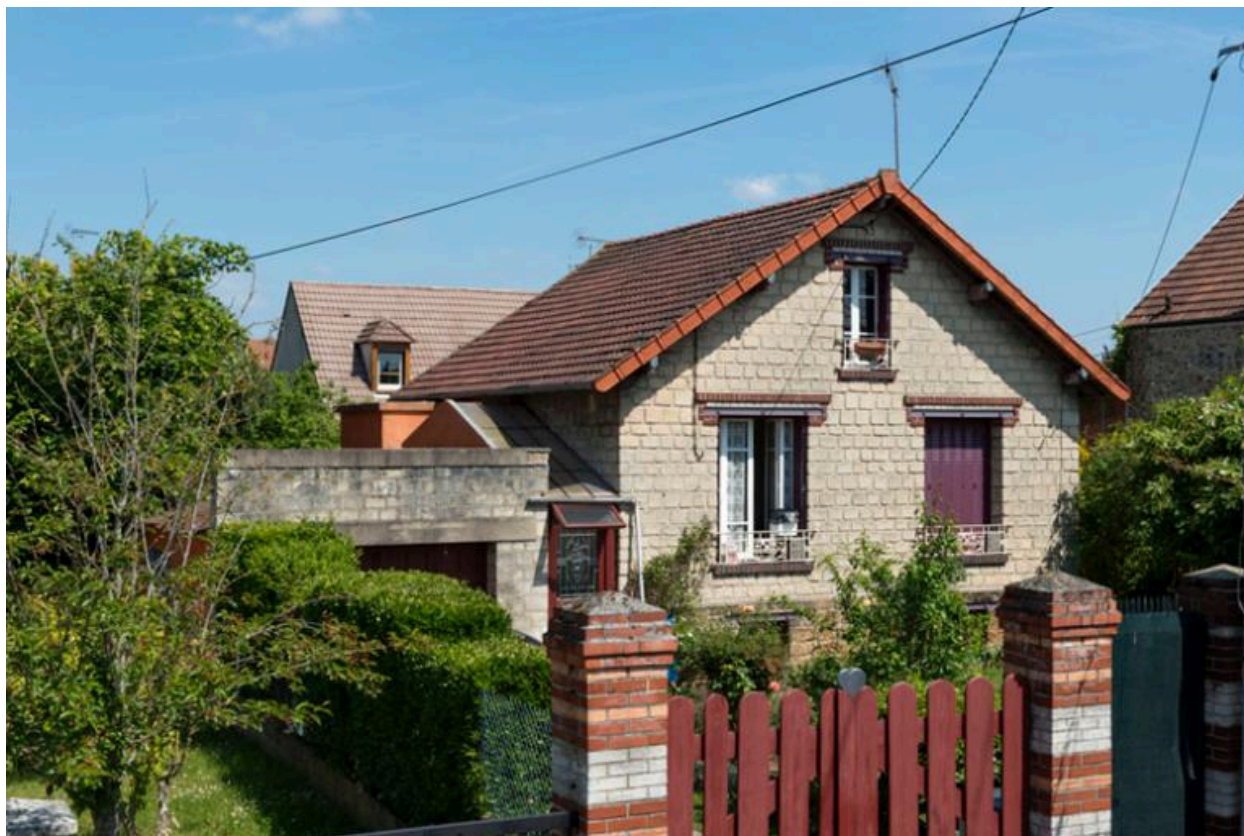
Les Mureaux. Pavillon, 15 rue Georges-Clémenceau.
