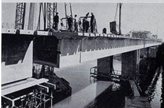
Fig. 15. — Voussoir de fléau en cours de pose. Le voussoir est encore suspendu à la bique. On distingue les clés de cisaillement et les logements des cônes.
