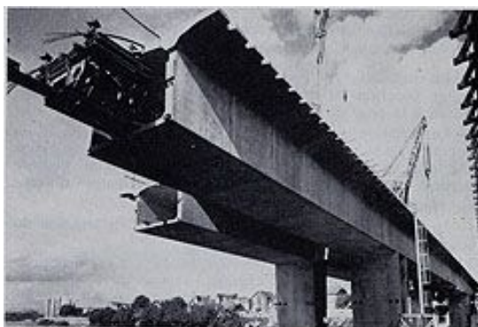
Fig. 14. — Fléau en cours de construction.
