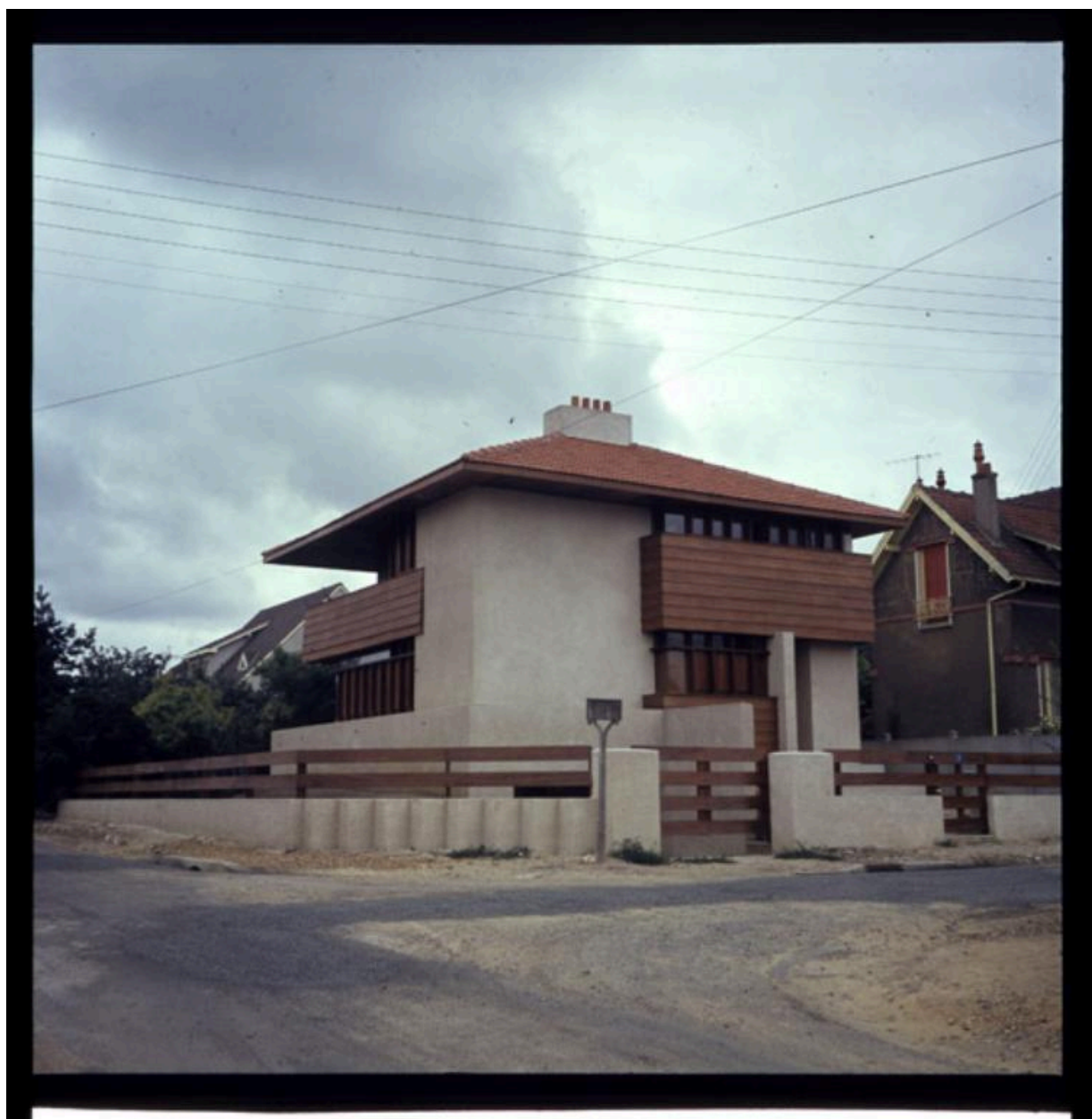
Vue ancienne de la Villa Lemoigne, côté portail d'entrée.
