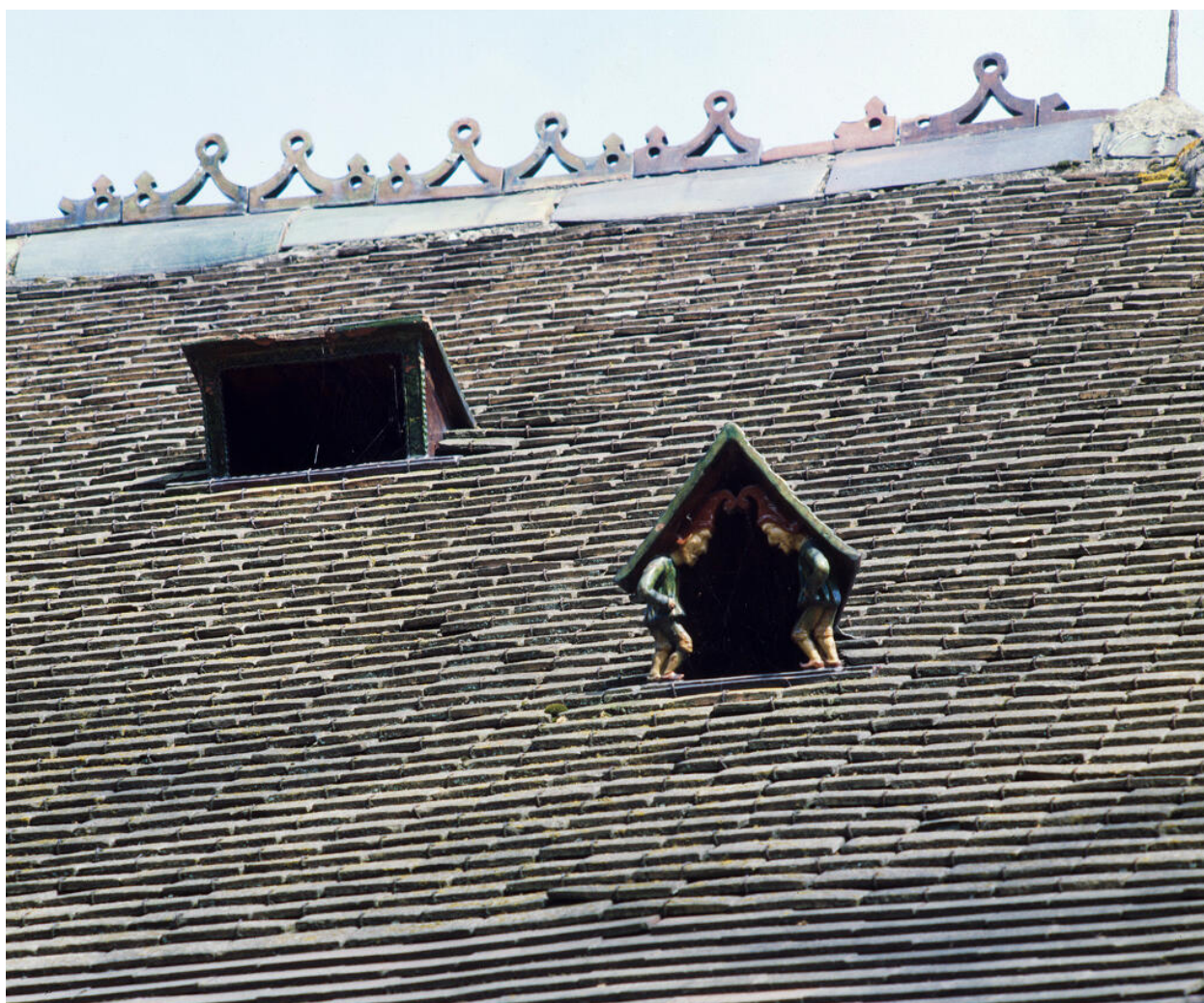
Détail de l'une des chatières sur le toit des communs : deux lutins se font face.
