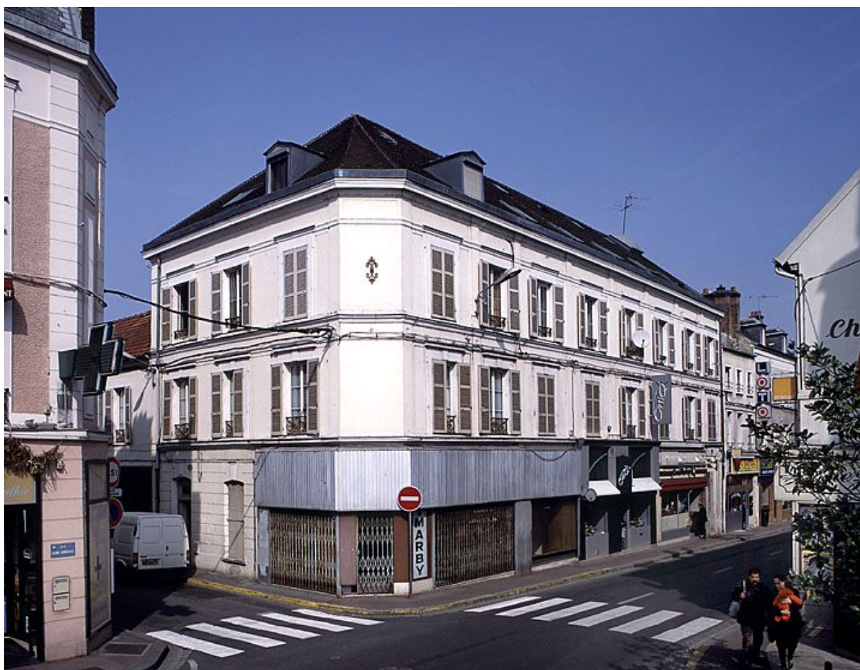
Immeuble du 19e siècle, combinant habitat, commerces et atelier. Vue d'ensemble.
