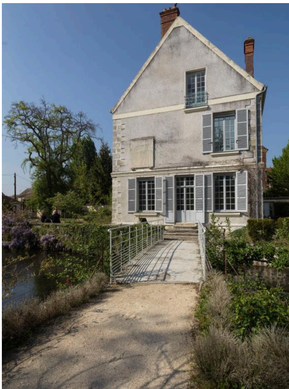
Vue du mur pignon du bâtiment principal (3)
