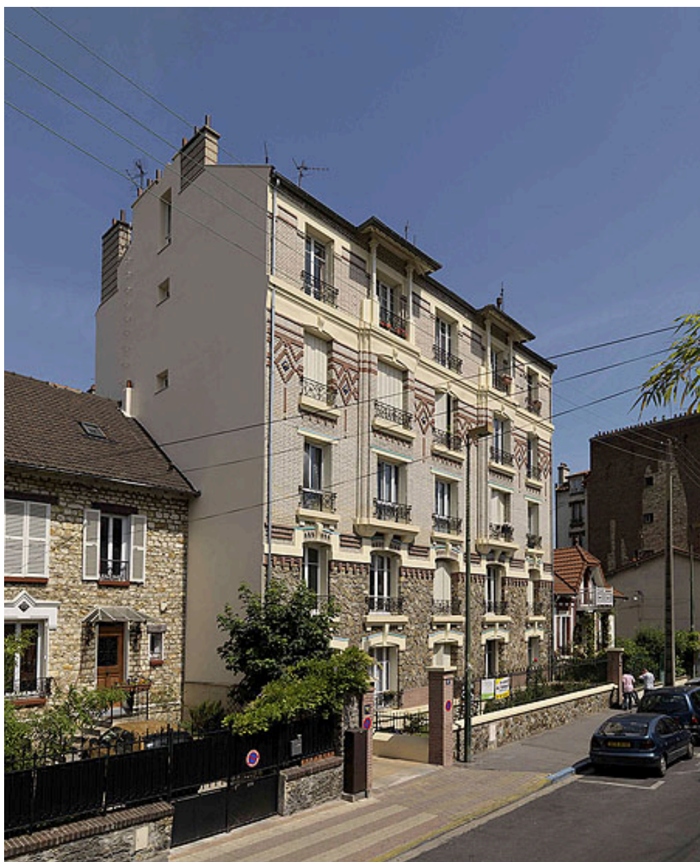
Vue d'ensemble d'un immeuble au 47 rue de la Barre
