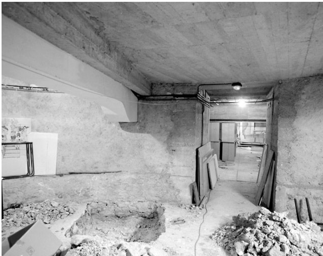
Fondations du chevet de l'ancienne église des Carmes, aujourd'hui convertie en salle de spectacles.
