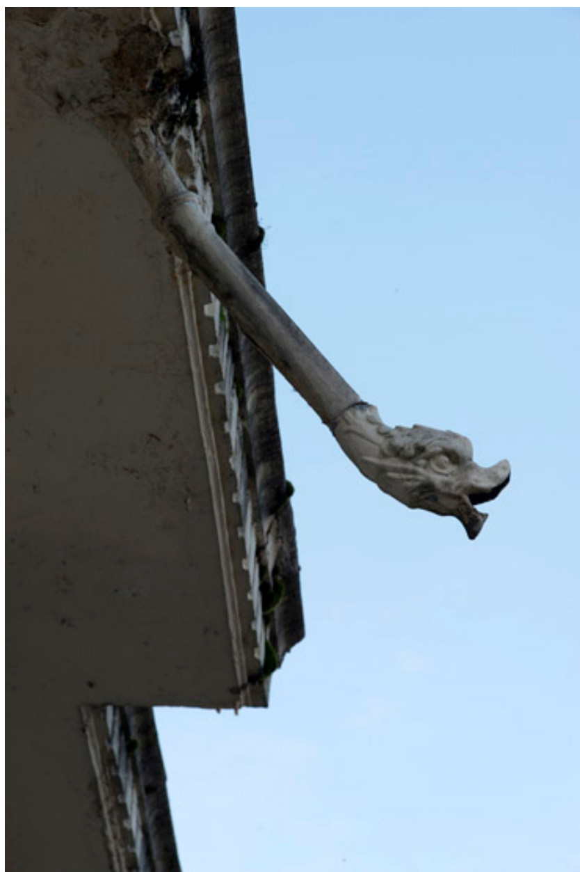
Maison, 33 avenue d'Ypres. Détail d'une gouttière.
